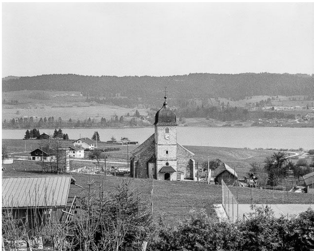
Vue sur la façade occidentale.
