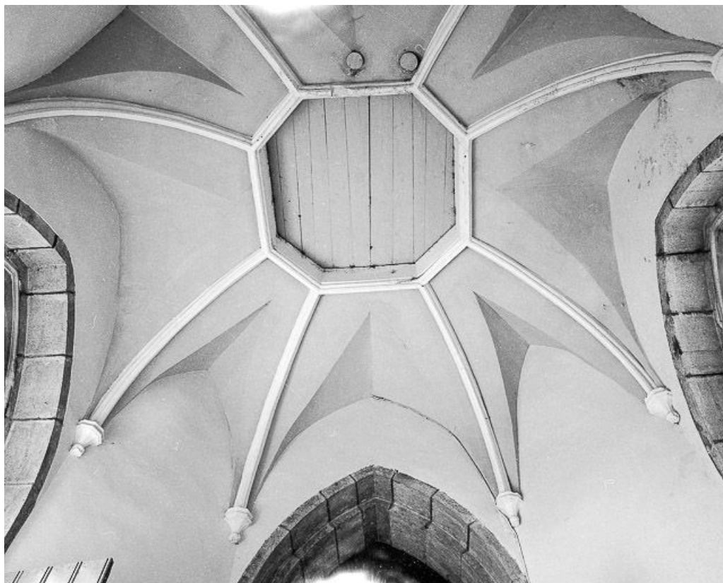
La voûte sous le clocher.
