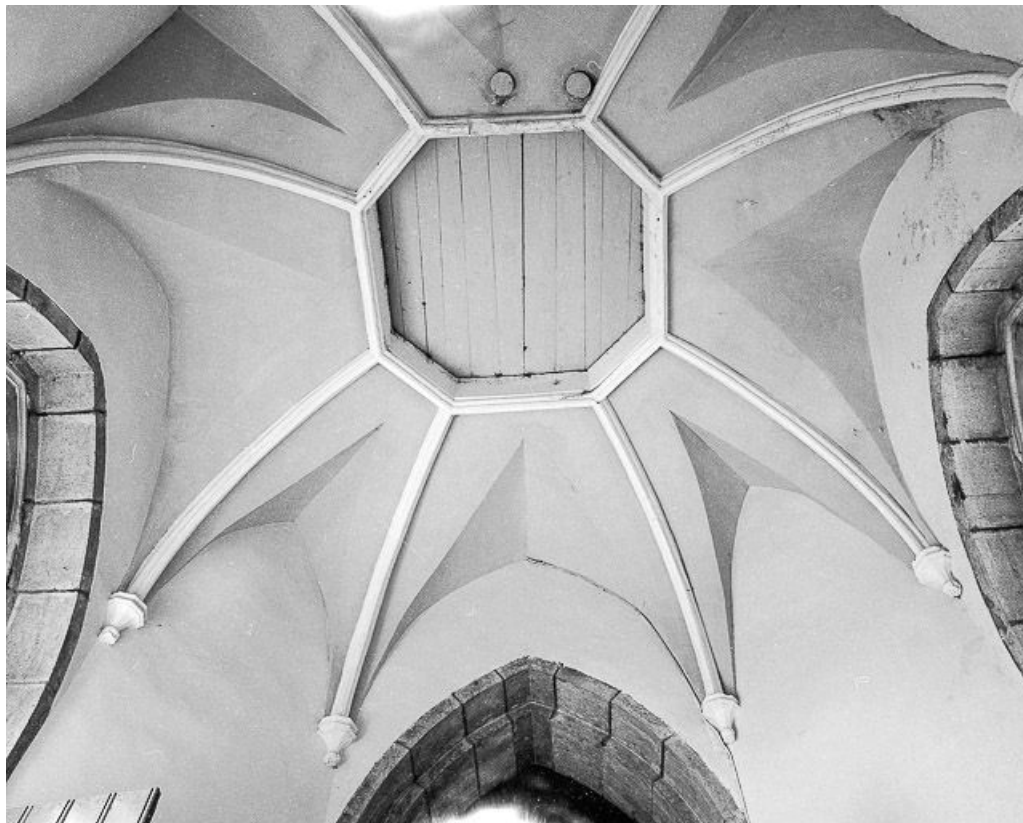
La voûte sous le clocher.
