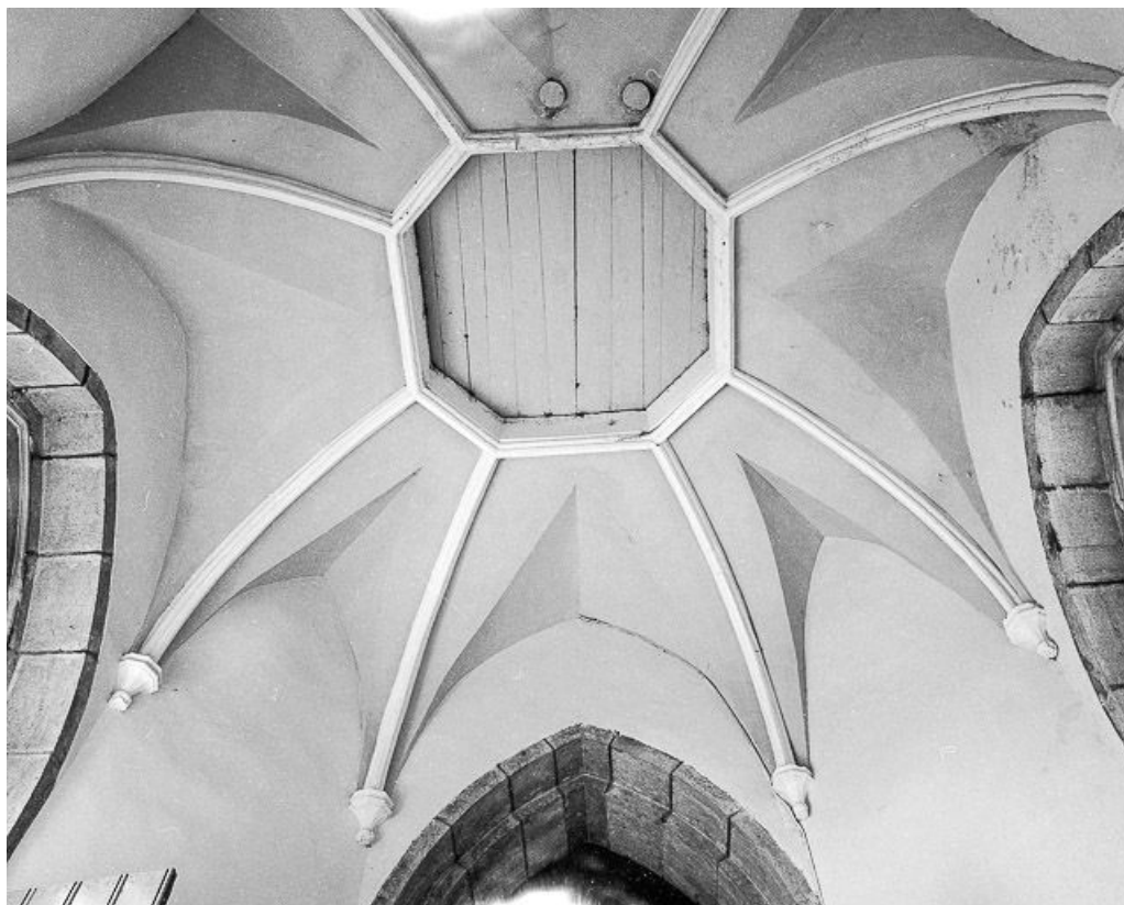
La voûte sous le clocher.
