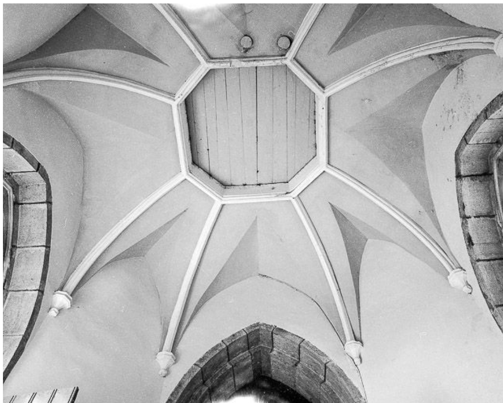
La voûte sous le clocher.
