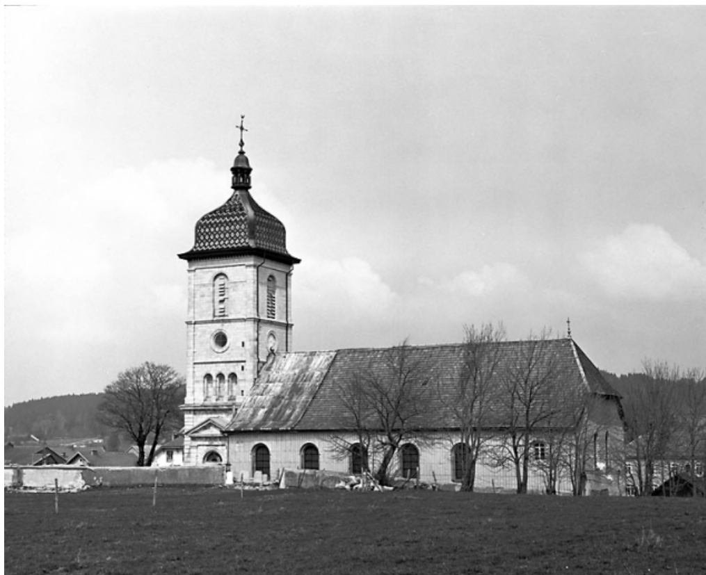
Vue de la façade sud.
