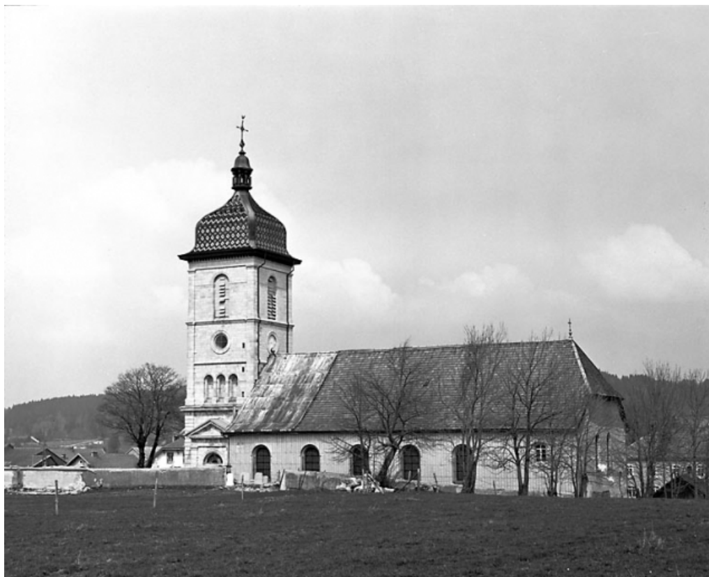
Vue de la façade sud.
