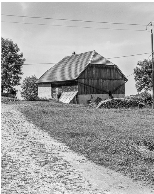
Façades postérieure et latérale droite.
