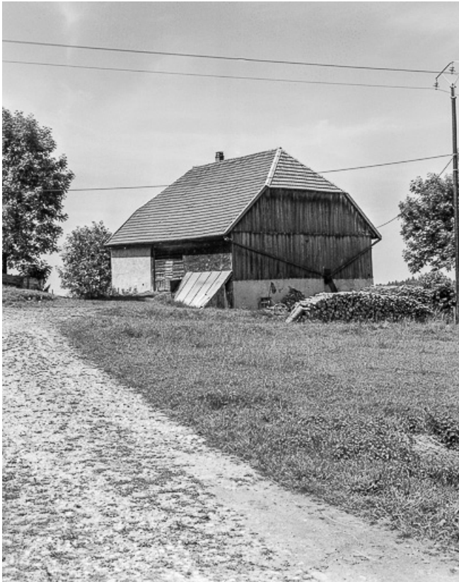
Façades postérieure et latérale droite.
