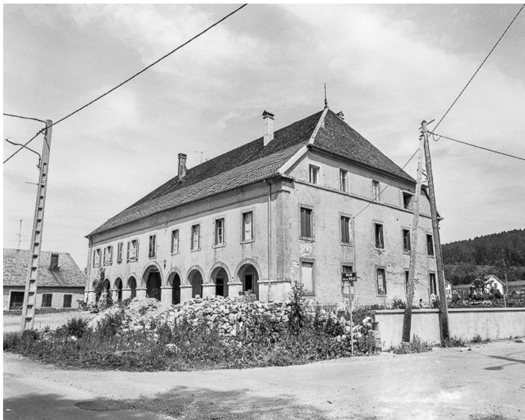
Façades antérieure et latérale droite.
