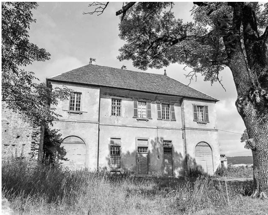
Façade sur rue. Vue de face. 25, Doubs
