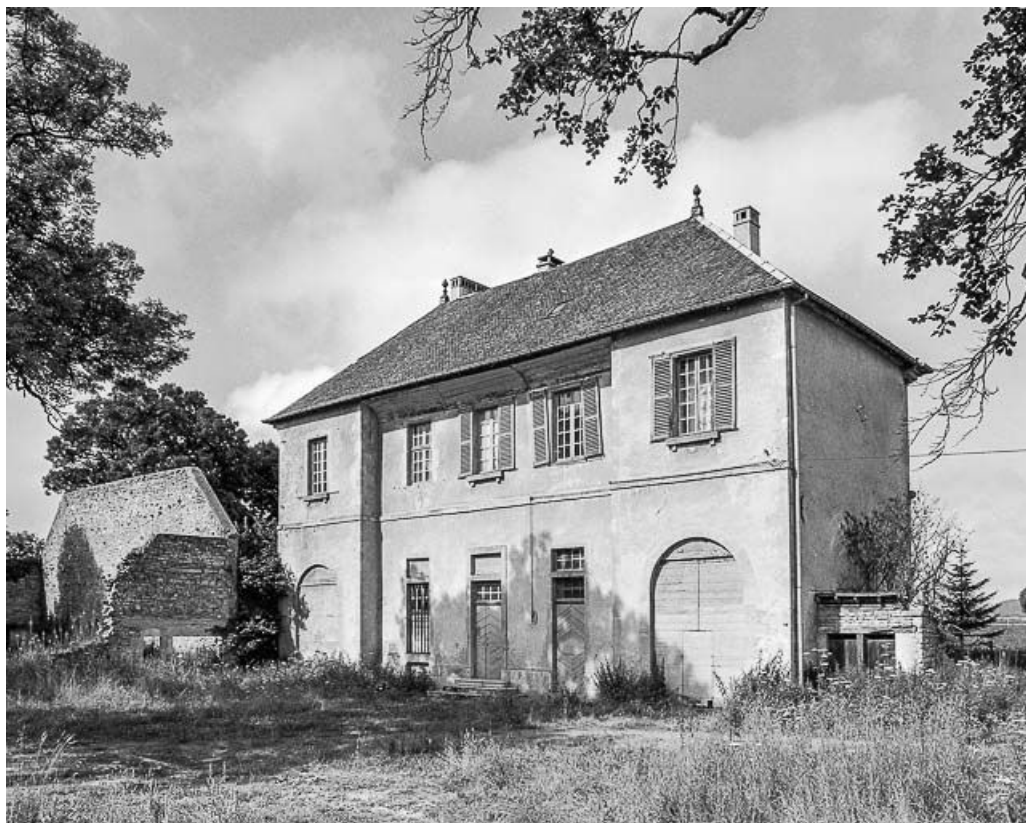
Façade sur rue. Vue de trois quarts. 25, Doubs
