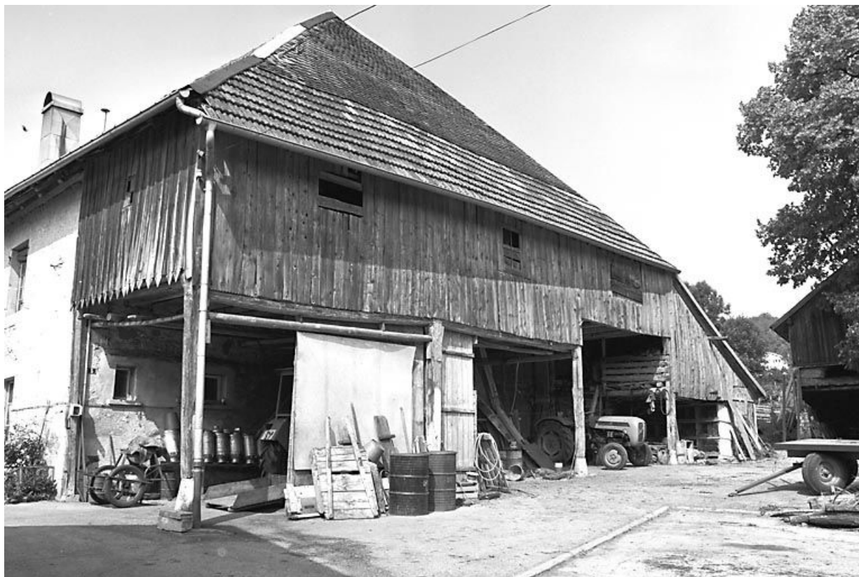
Façade latérale droite.
