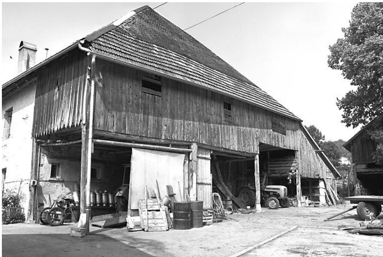
Façade latérale droite.
