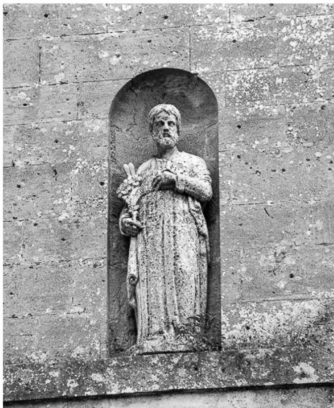
Ensemble de trois statues au-dessus du portail : saint Josph.
