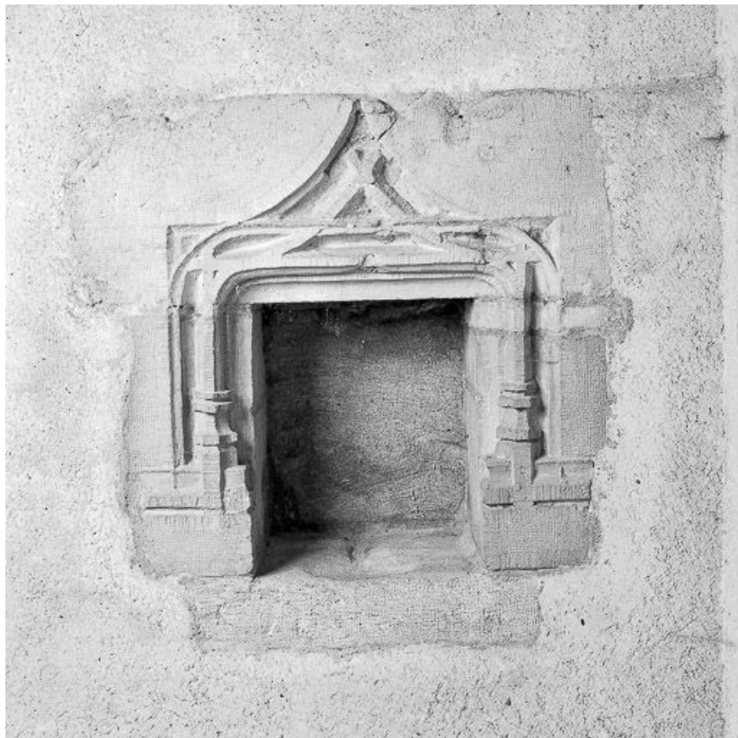
Niche dans un mur intérieur.
