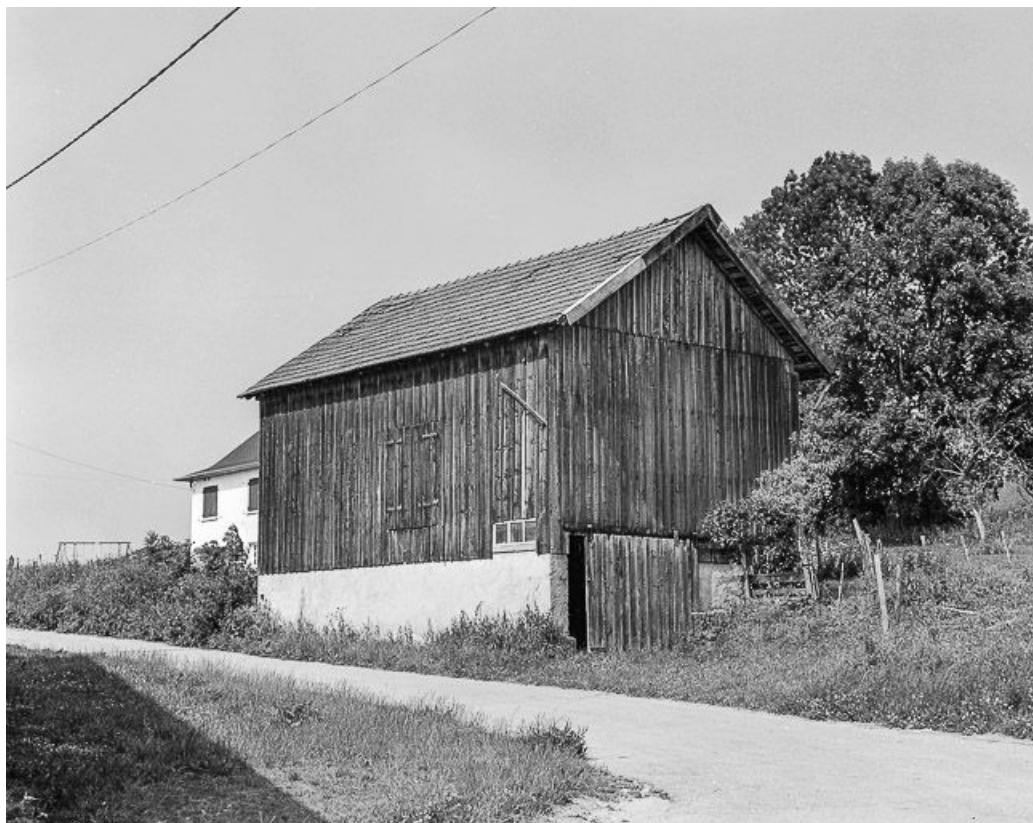
Remise cadastrée 1933 B1 94 : vue d'ensemble. 25, Dommartin
