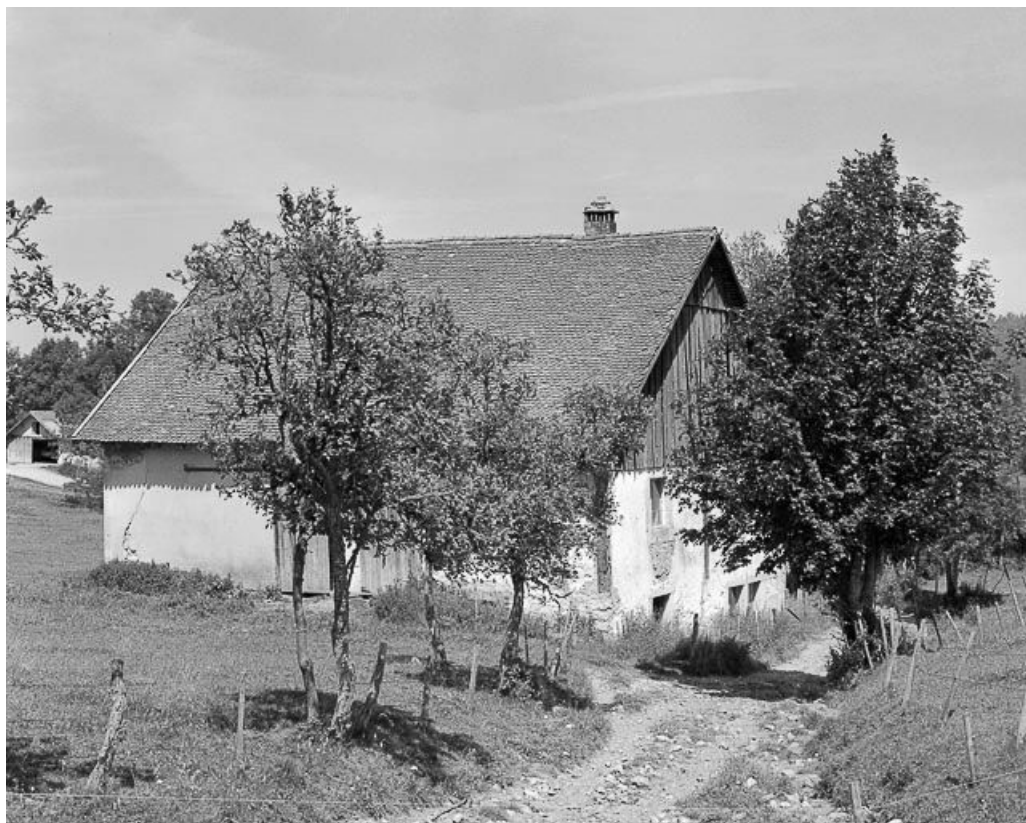
Façade antérieure et latérale gauche.
