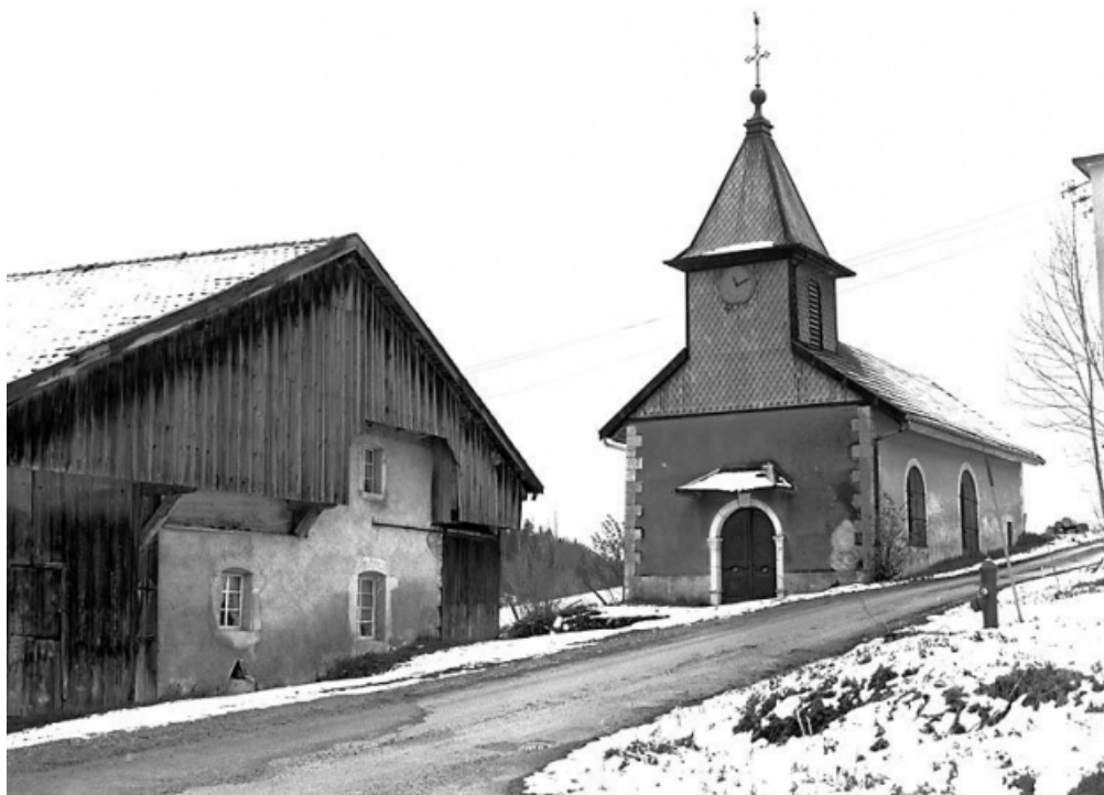
Vue de la façade occidentale.
