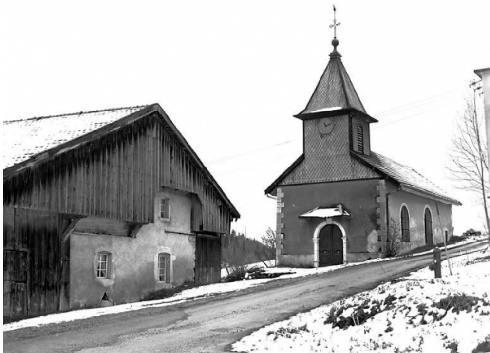
Vue de la façade occidentale.
