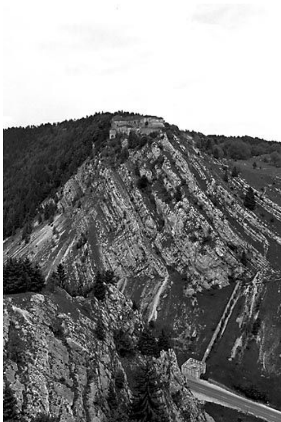
Vue du fort et de l'ouvrage défendant la route.
