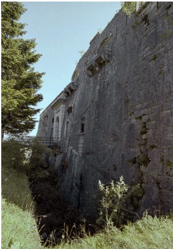
Entrée du fort et front de gorge. Vue verticale.
