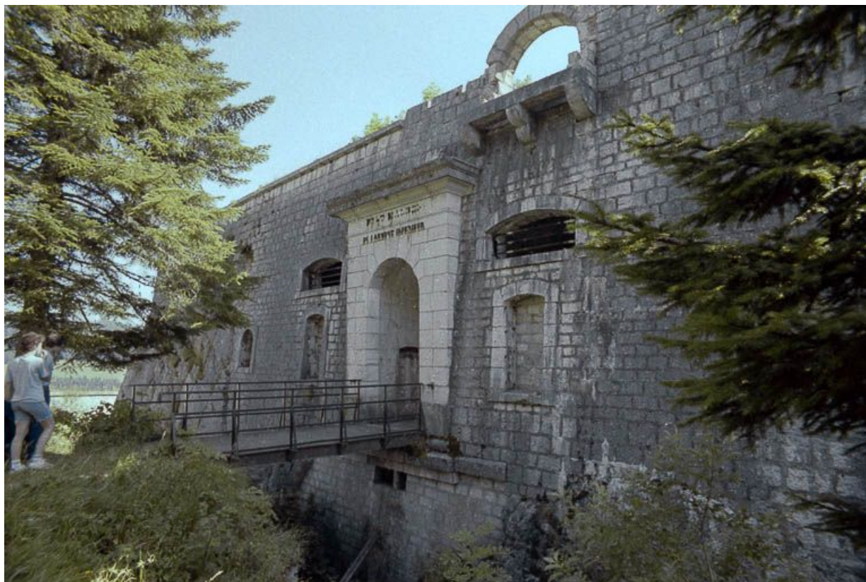
Vue horizontale sur le front de gorge.
