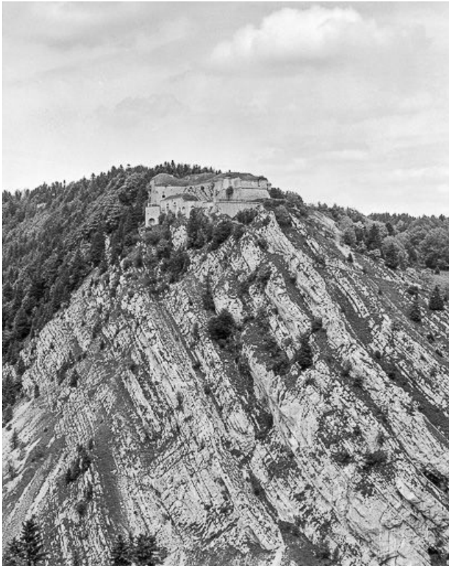
Vue moyenne du site du Larmont inférieur, depuis le château de Joux.
