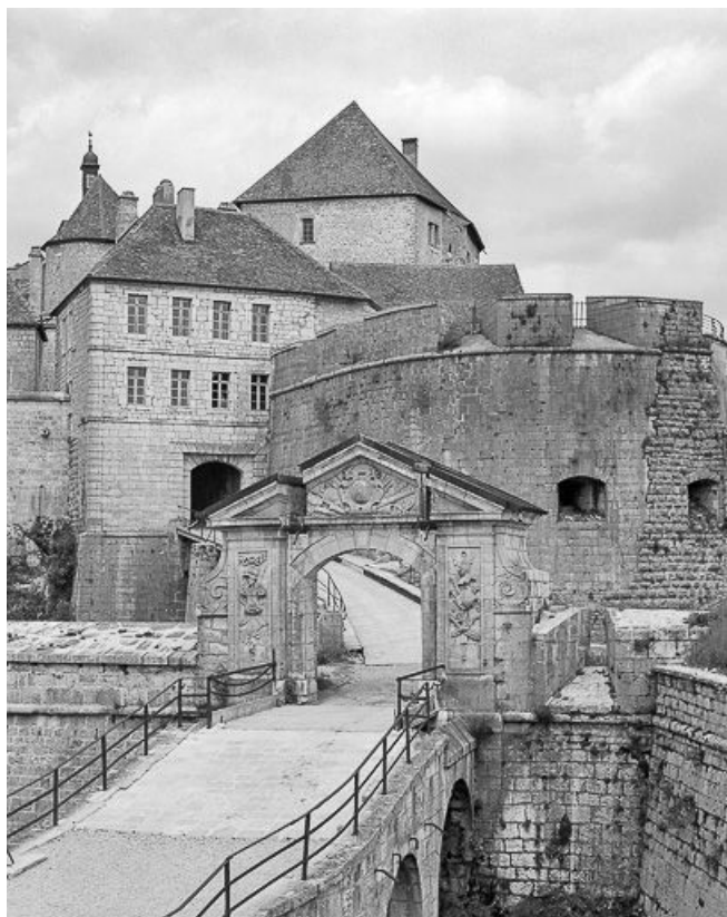
Vue moyenne. Porte Louis XIV - tour bastionnée de la 4e enceinte. En arrière-plan : tour en "fer à cheval" et 3e enceinte. 25, La Cluse-et-Mijoux, lieudit : au Fort de Joux
