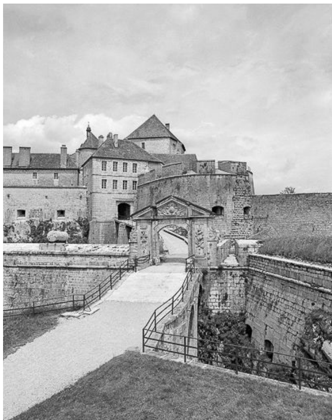
Vue éloignée. Porte Louis XIV - tour bastionnée de la 4e enceinte. En arrière-plan : tour en "fer à cheval" et 3e enceinte. 25, La Cluse-et-Mijoux, lieudit : au Fort de Joux
