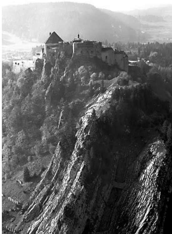
Vue d'ensemble depuis le fort du Larmont inférieur.
