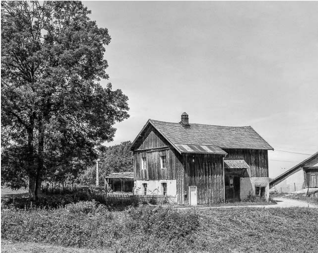
Ferme au lieu-dit Montpetot : façades antérieure et latérale droite.
