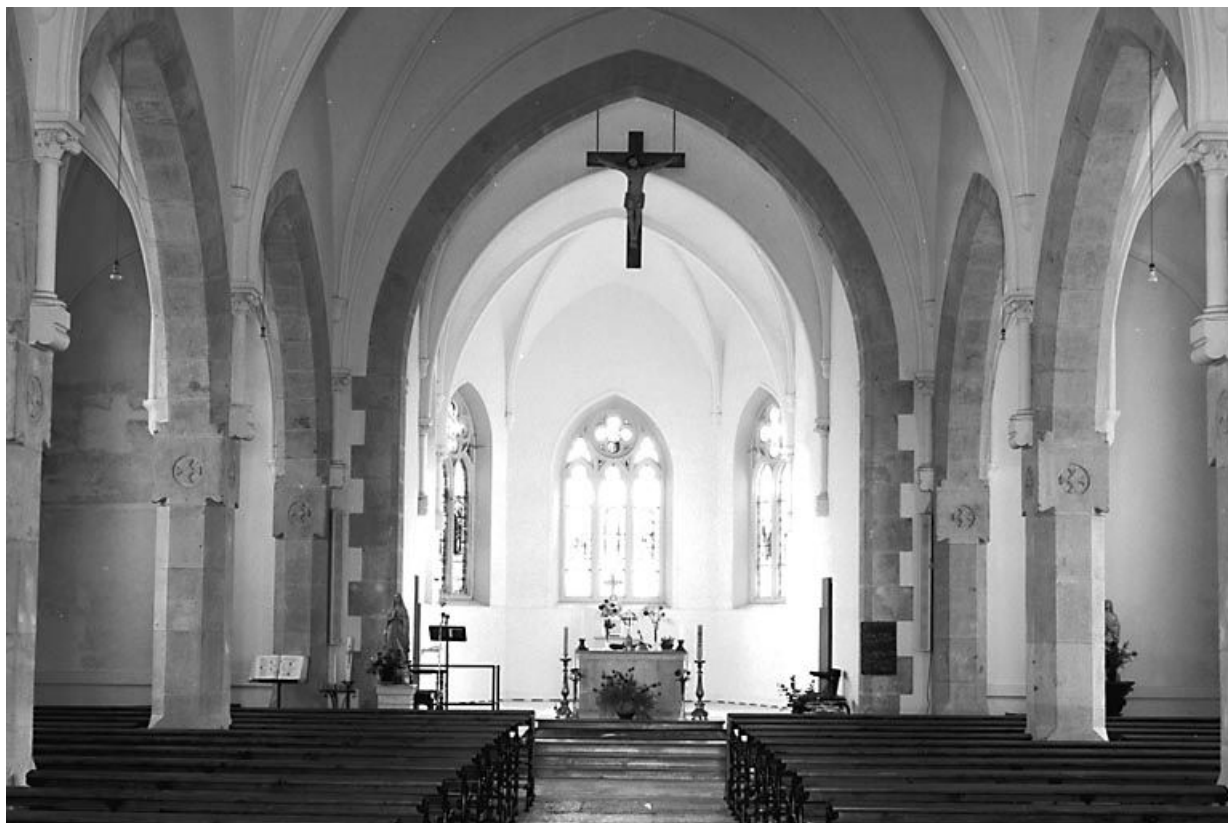
Vue de la nef et du choeur depuis l'entrée. 25, Chaffois
