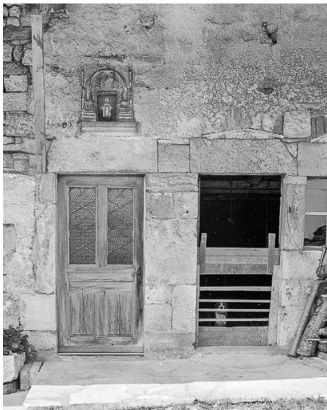
Détail des ouvertures sur rue.
