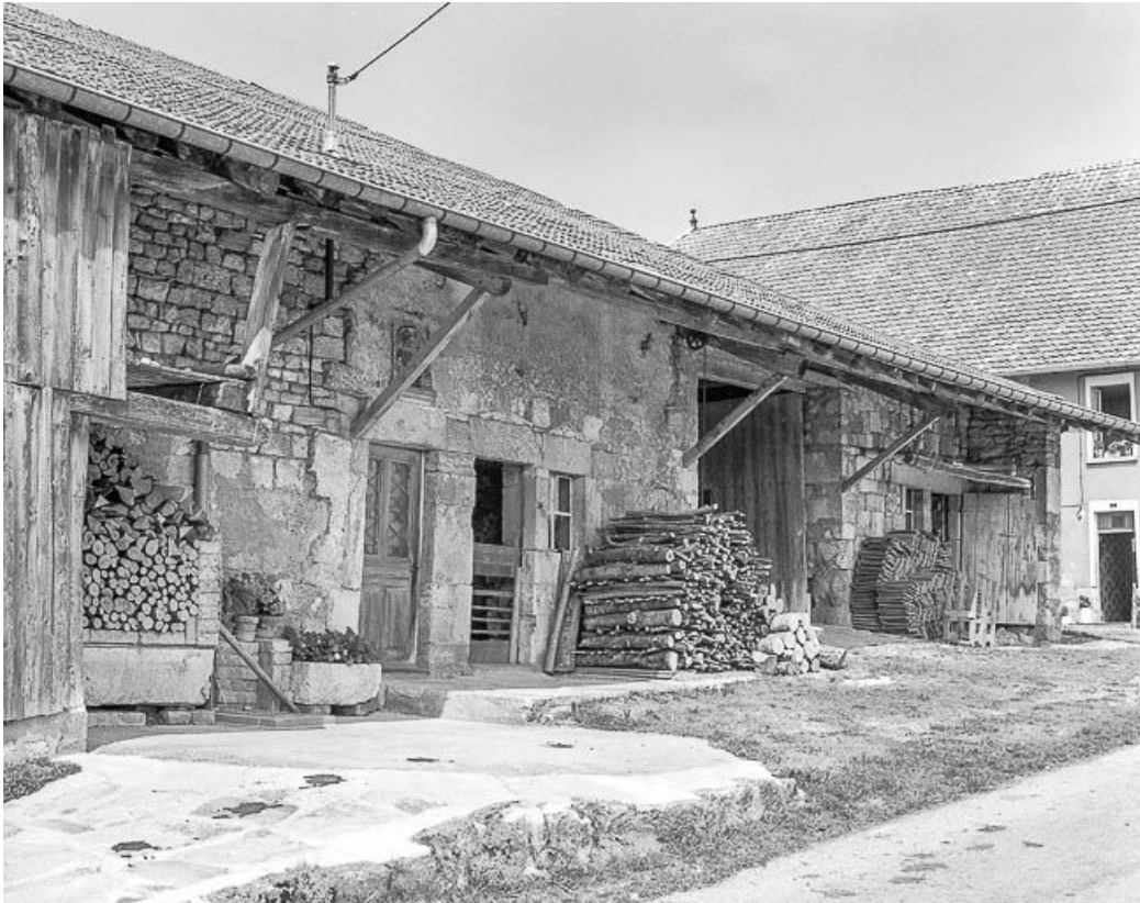
Goutterot sur rue.
