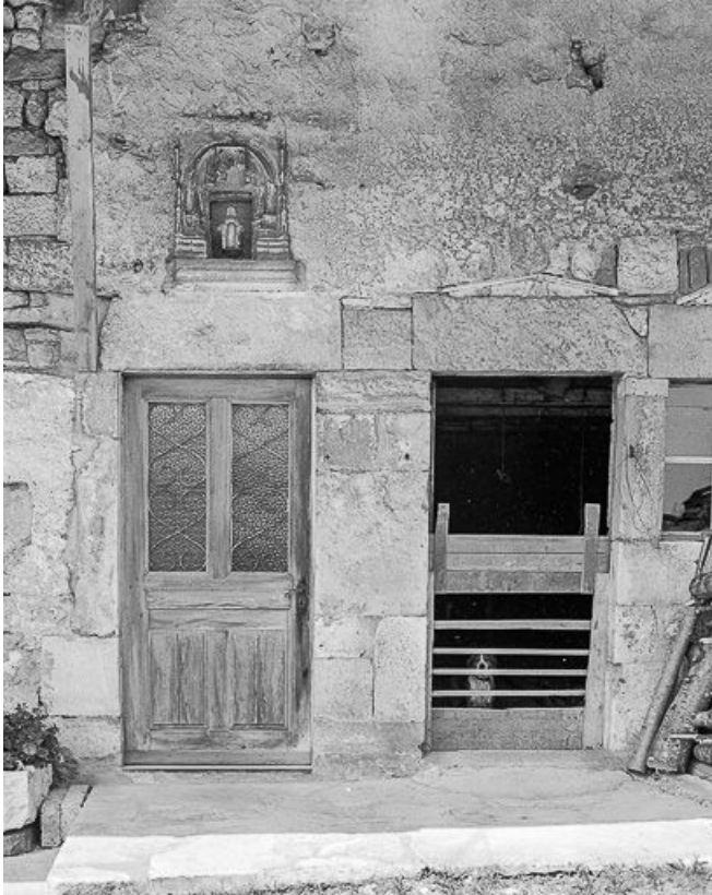
Détail des ouvertures sur rue.
