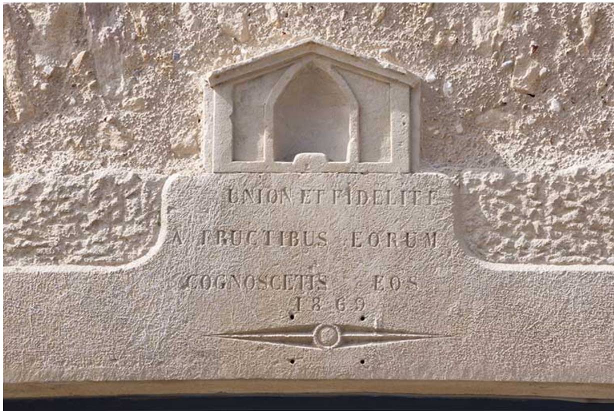
Mur-pignon est. Détail du linteau.
