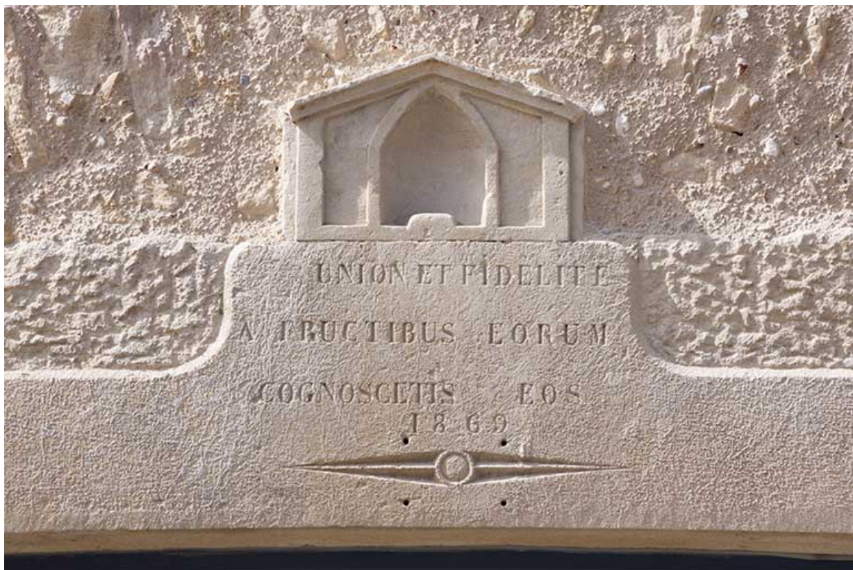
Mur-pignon est. Détail du linteau.
