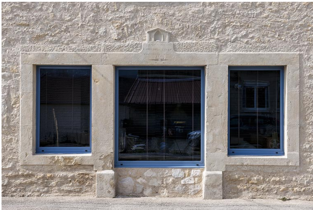
Ouvertures du mur-pignon est. 25, Bouverans, 10 rue du Leussus
