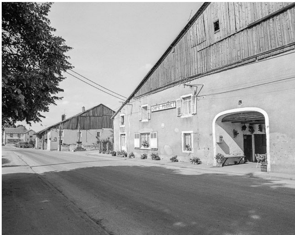
Façade antérieure, détail.
