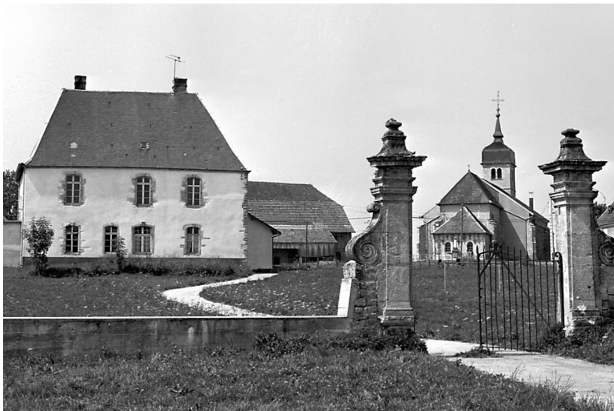
Façade sur le parc.
