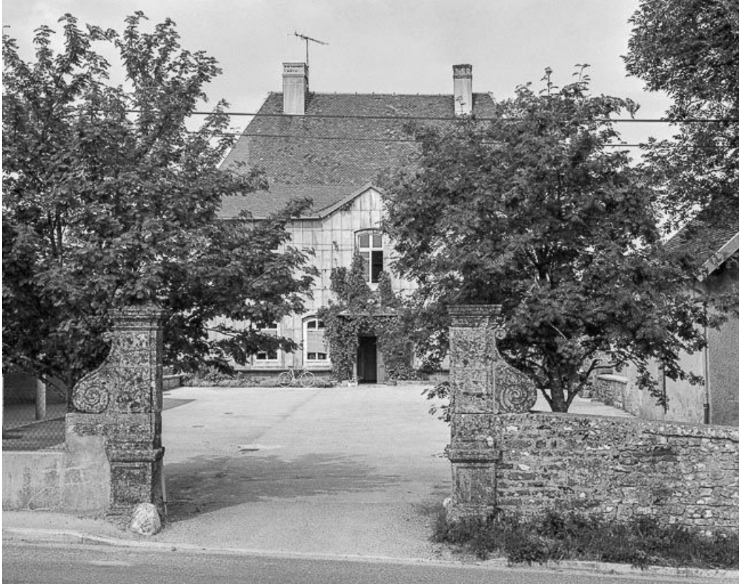
Façade sur rue. 25, Bannans
