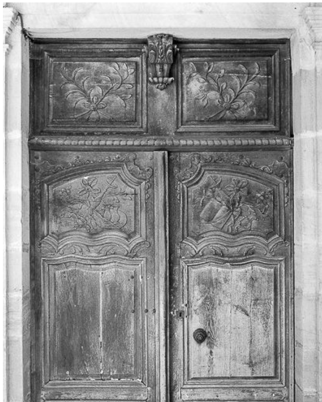
Vue d'ensemble de la deuxième porte d'entrée.
