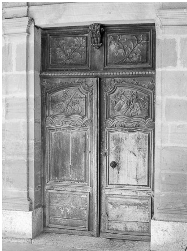
Détail de la deuxième porte d'entrée.
