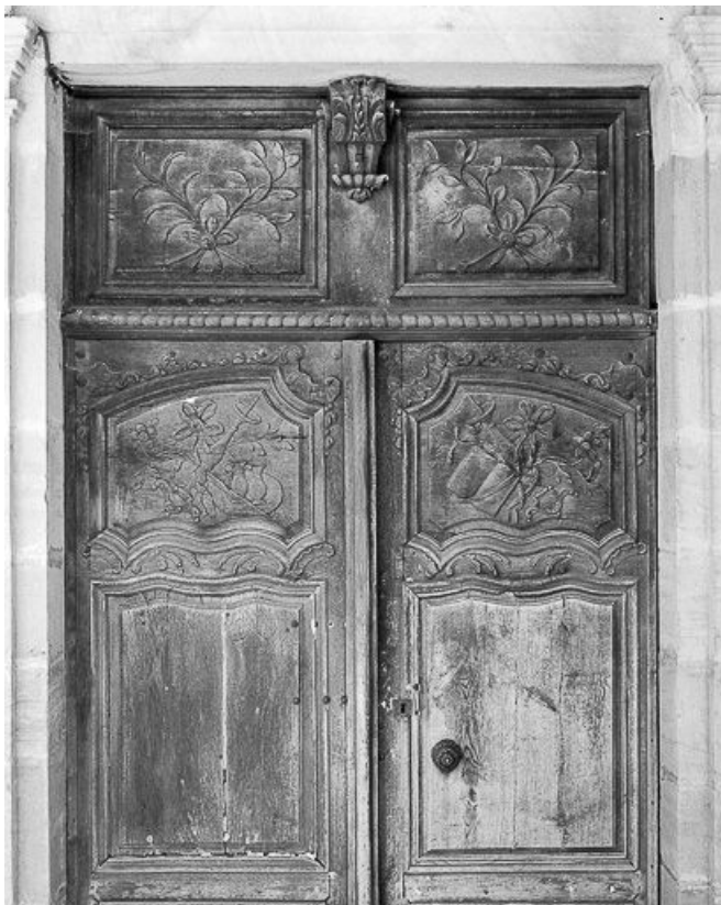
Vue d'ensemble de la deuxième porte d'entrée.
