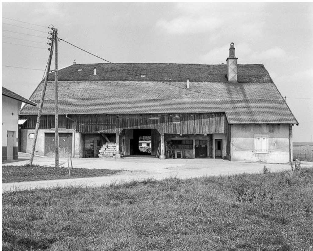
Façade latérale droite.
