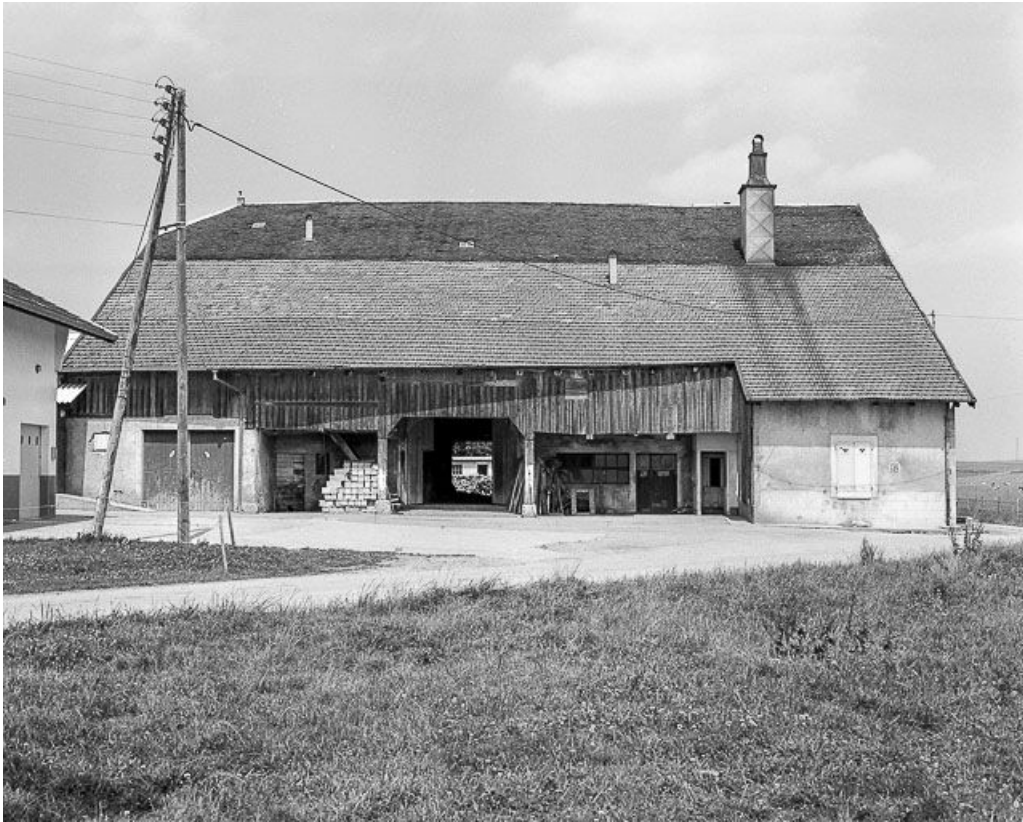
Façade latérale droite.
