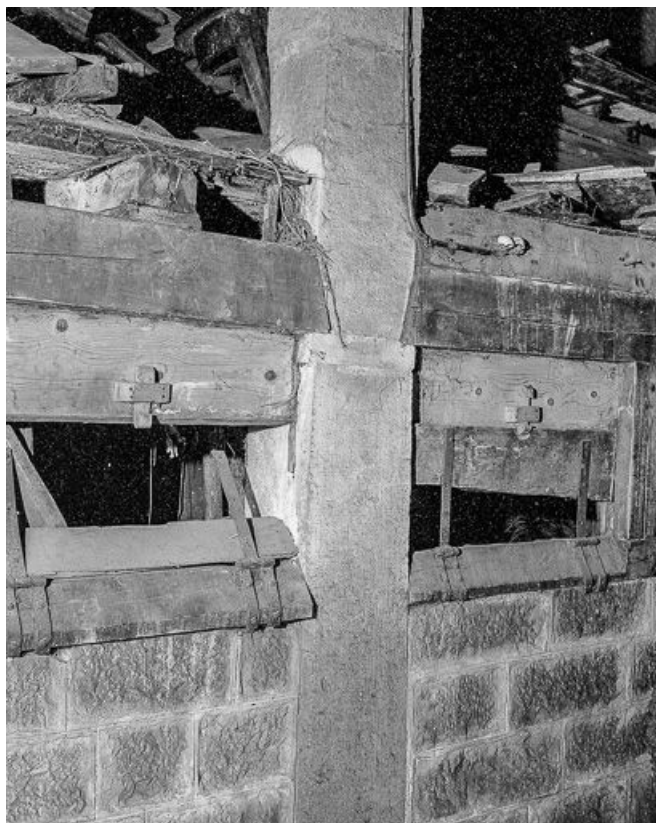
Partie inférieure en pierre de taille d'un poteau de charpente.
