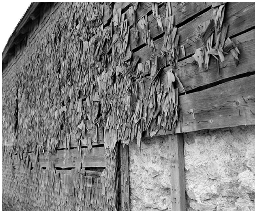
Façade latérale droite en 1978. Elle est protégée par un essentage de bardeaux cloués. 25, Les Villedieu rue Principale
