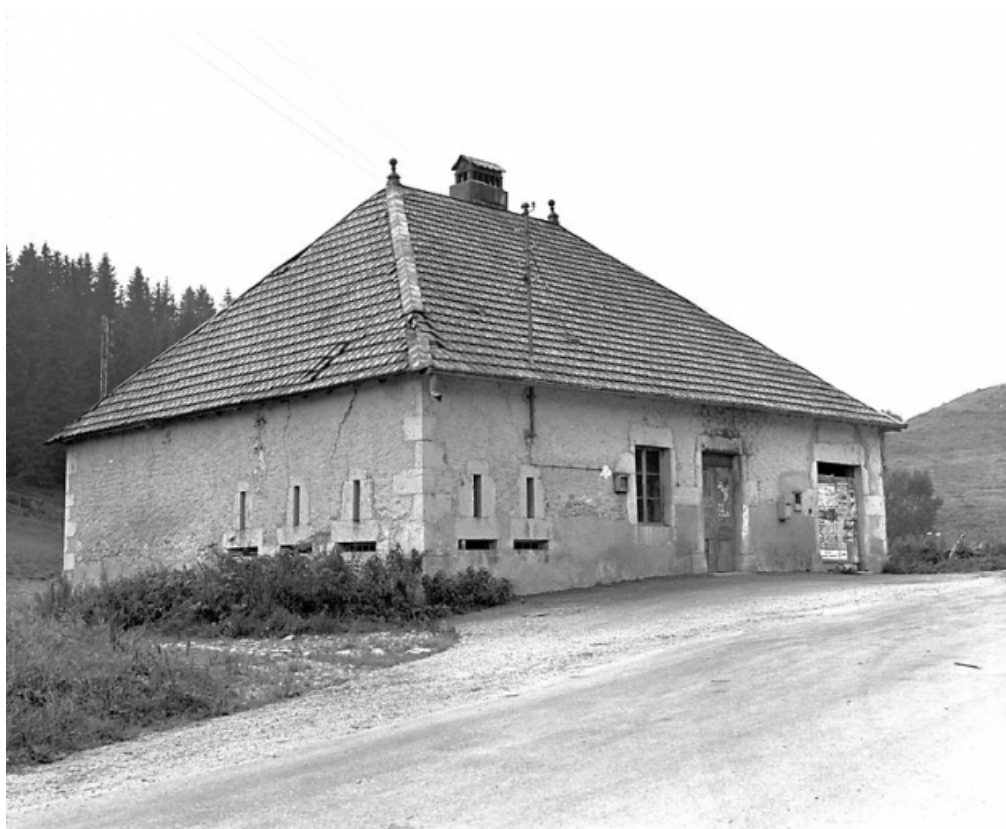
Façades antérieure et latérale gauche.
