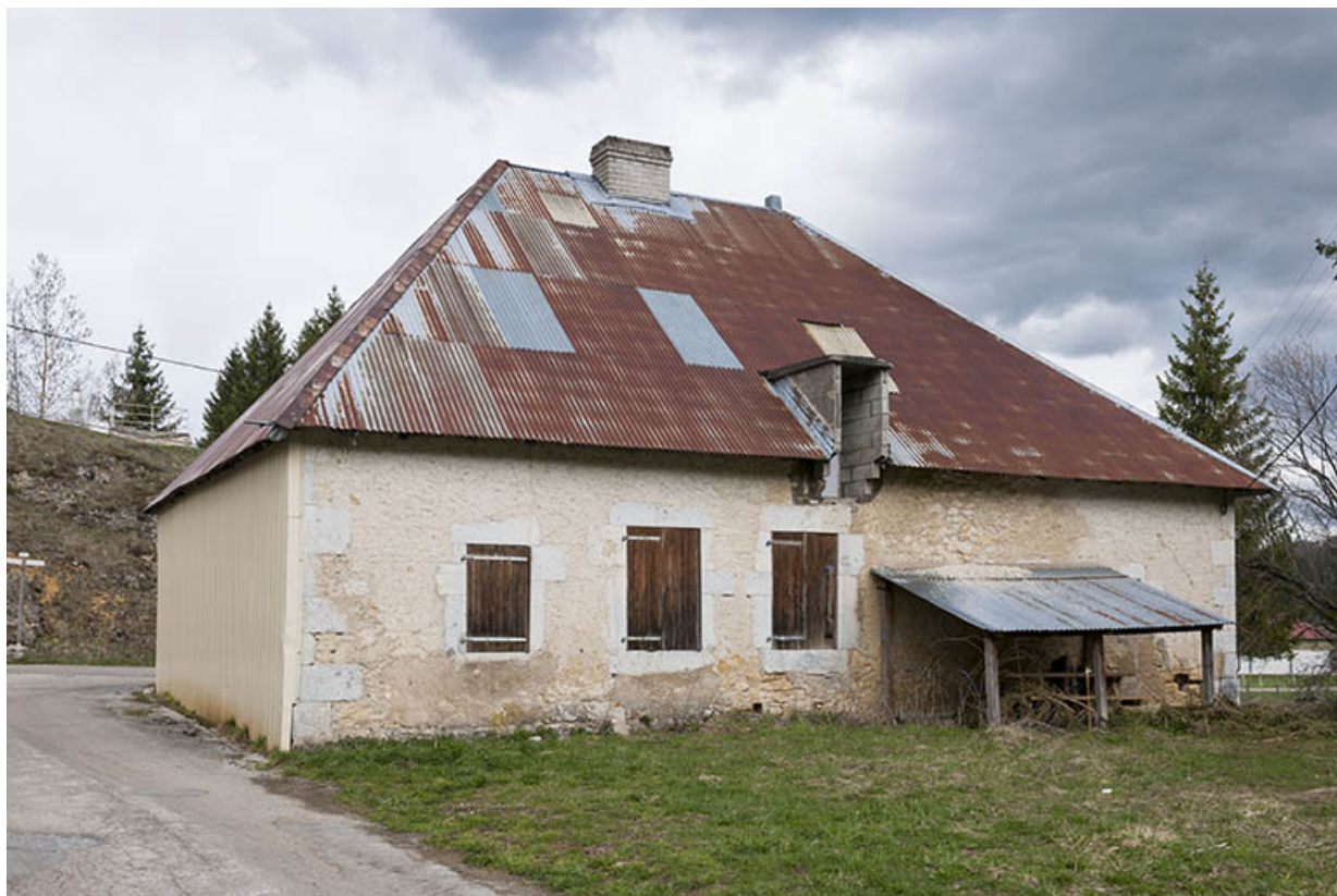
Façades postérieure et latérale droite en 2016.
