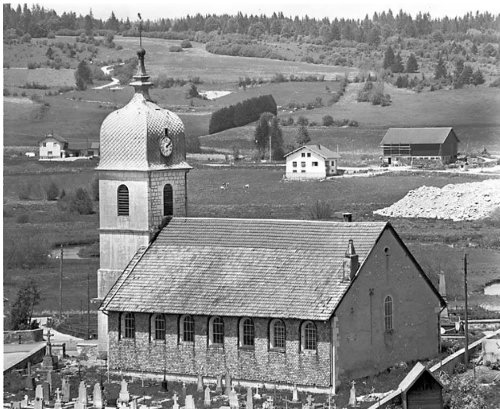
Façades postérieure et latérale droite.
