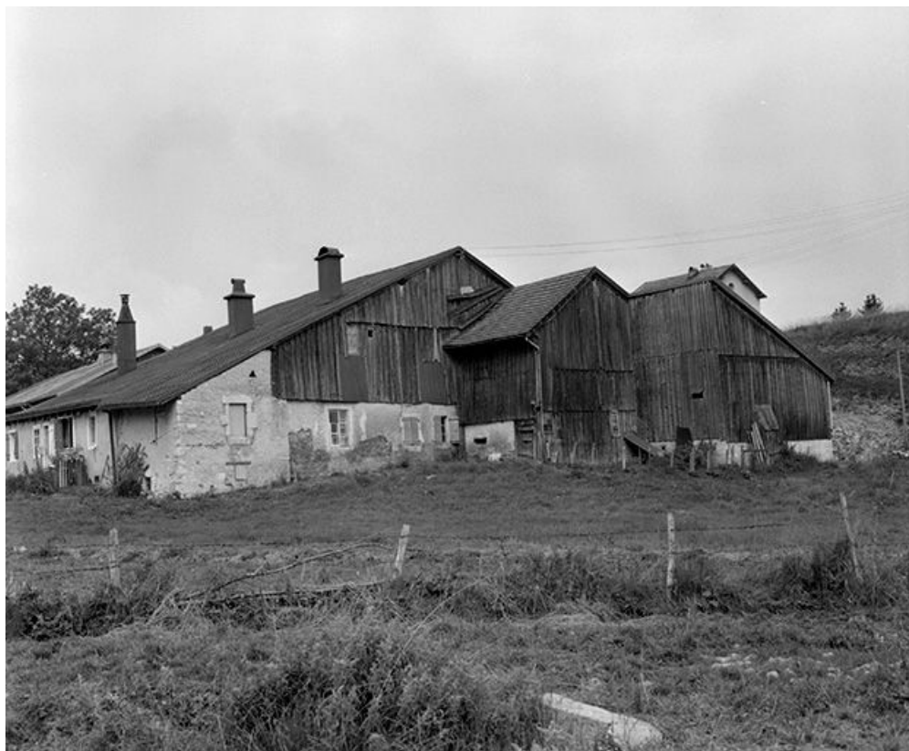
Ferme à Villedieu-les-Rochejean : façade antérieure et latérale droite. 25, Les Villedieu
