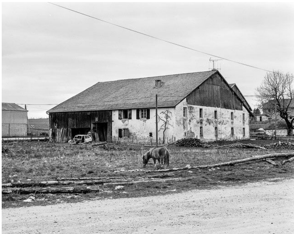
Façades postérieure et latérale gauche. 25, Malpas rue Principale, lieudit : Malpas
