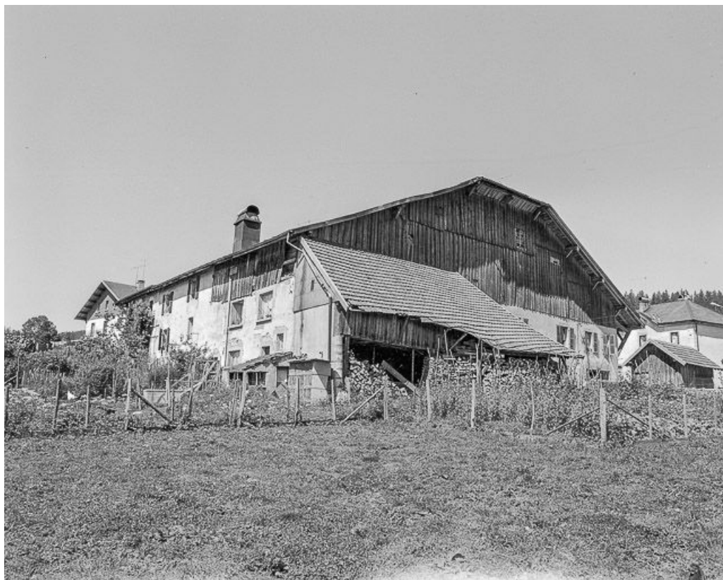
Ferme située à Chantegrue : façades postérieure et latérale gauche. 25, Vaux-et-Chantegrue
