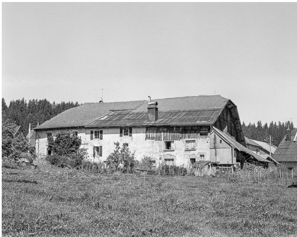
Ferme située à Chantegrue : façades postérieure et latérale gauche. 25, Vaux-et-Chantegrue
