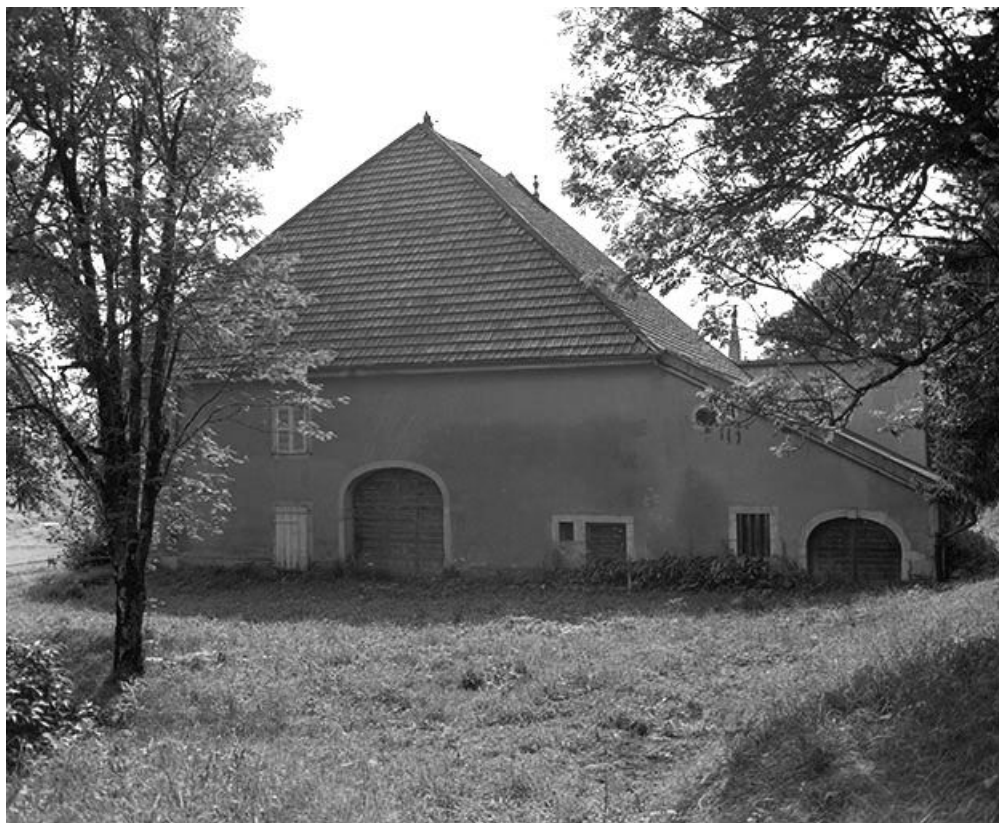
Façade latérale, vue depuis le parc.
