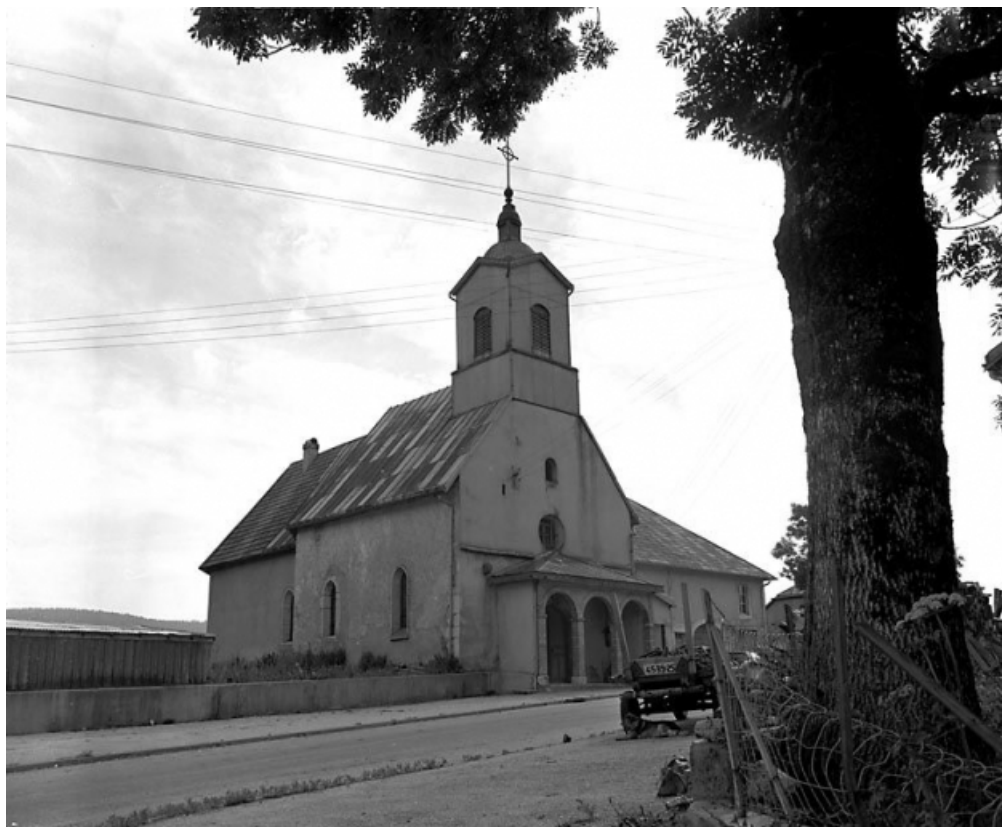
Façades antérieure et latérale gauche. 25, Sarrageois
