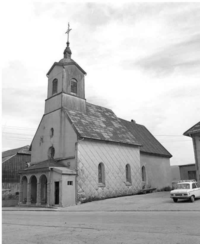
Façades antérieure et latérale droite. 25, Sarrageois
