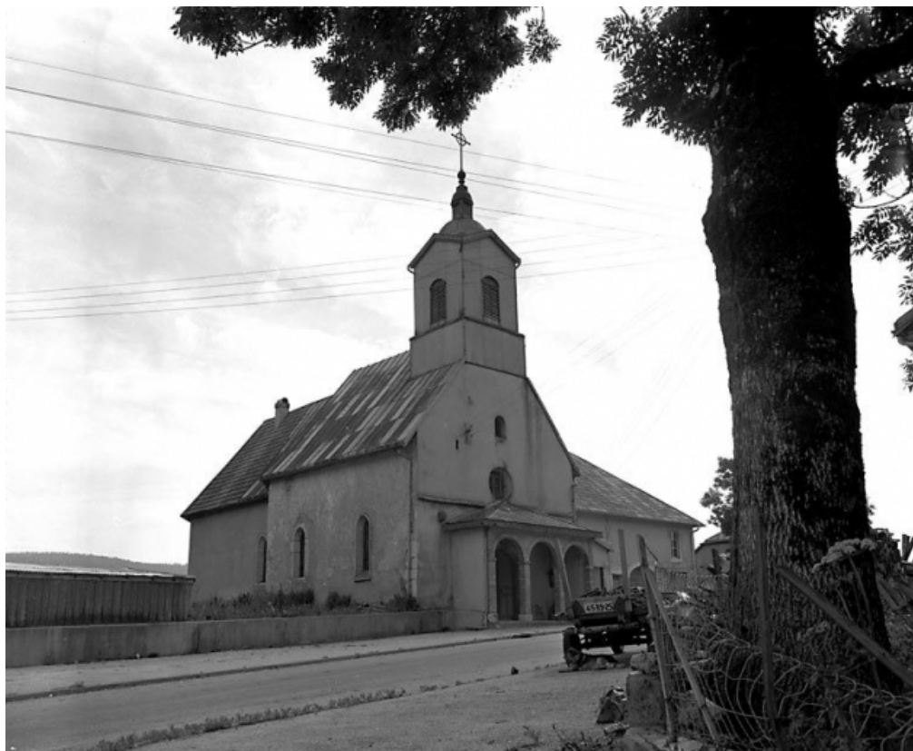
Façades antérieure et latérale gauche. 25, Sarrageois
