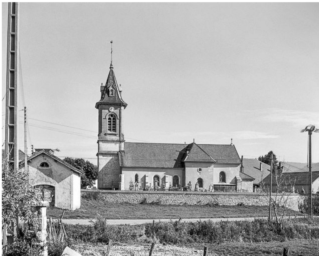
Façade latérale droite.
