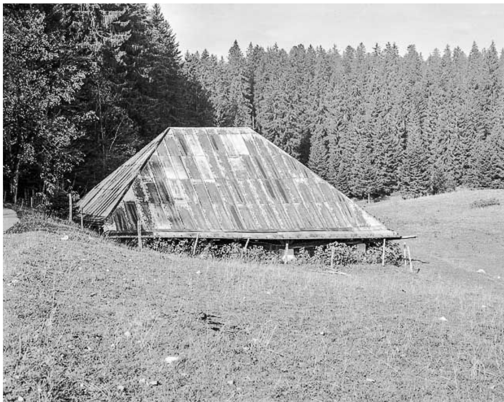
Vue d'ensemble dans le site.
