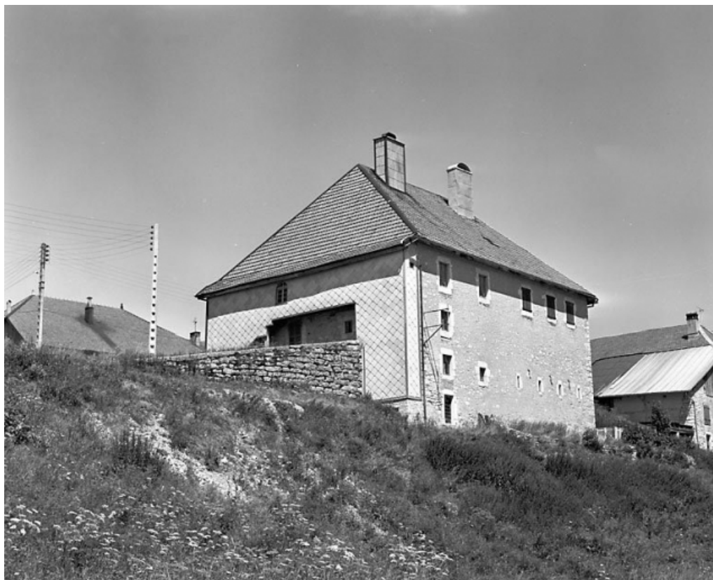
Façades postérieure et latérale droite.
