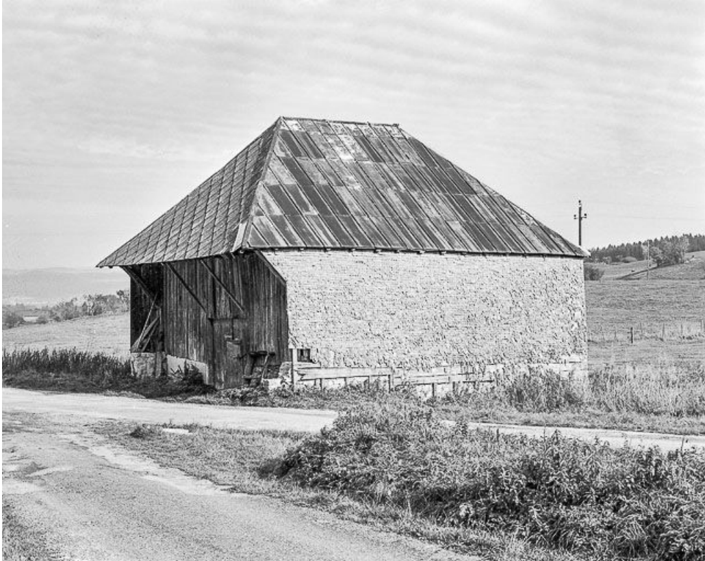
Bâtiment servant de remise.
