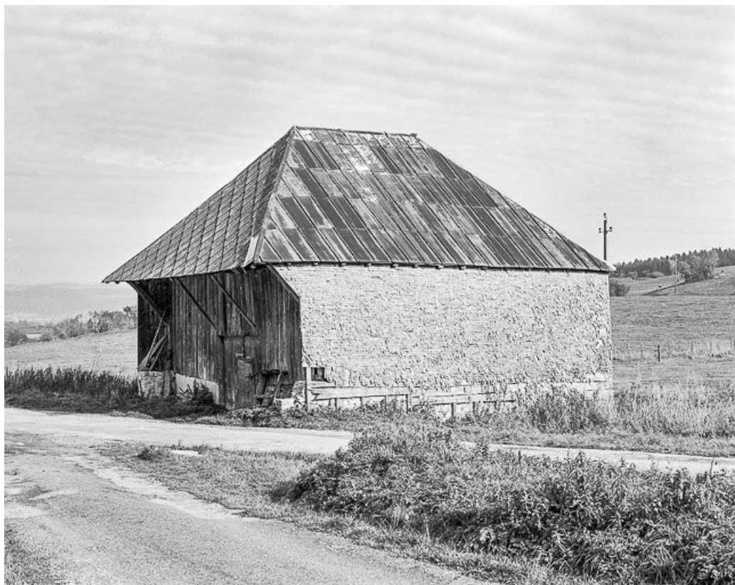
Bâtiment servant de remise.
