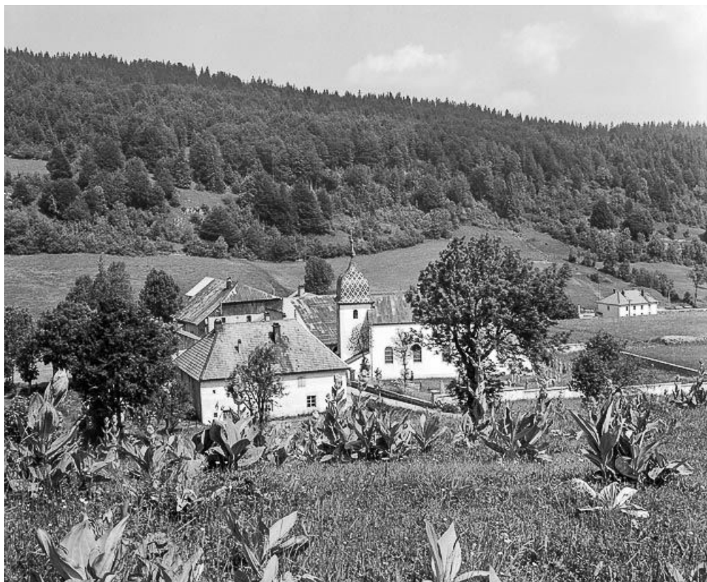
Vue d'ensemble du hameau de Boujeons, depuis le Sud.
