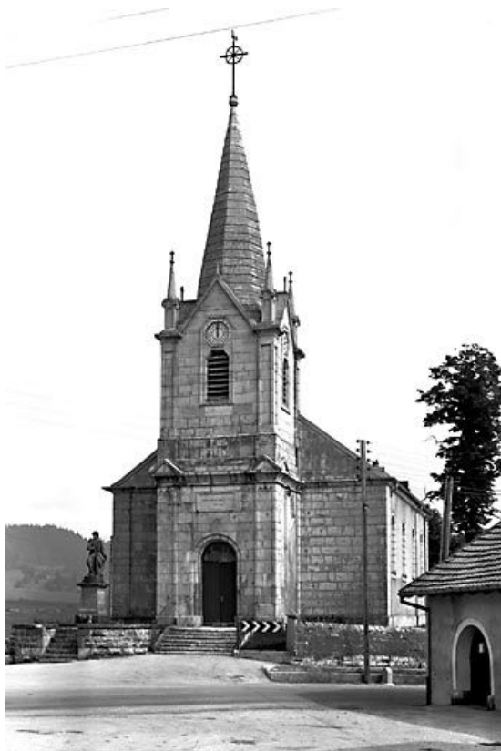
Façades antérieure et latérale droite.
