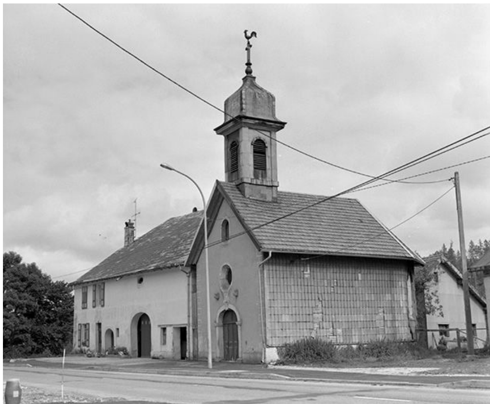
Façades antérieure et latérale droite.
