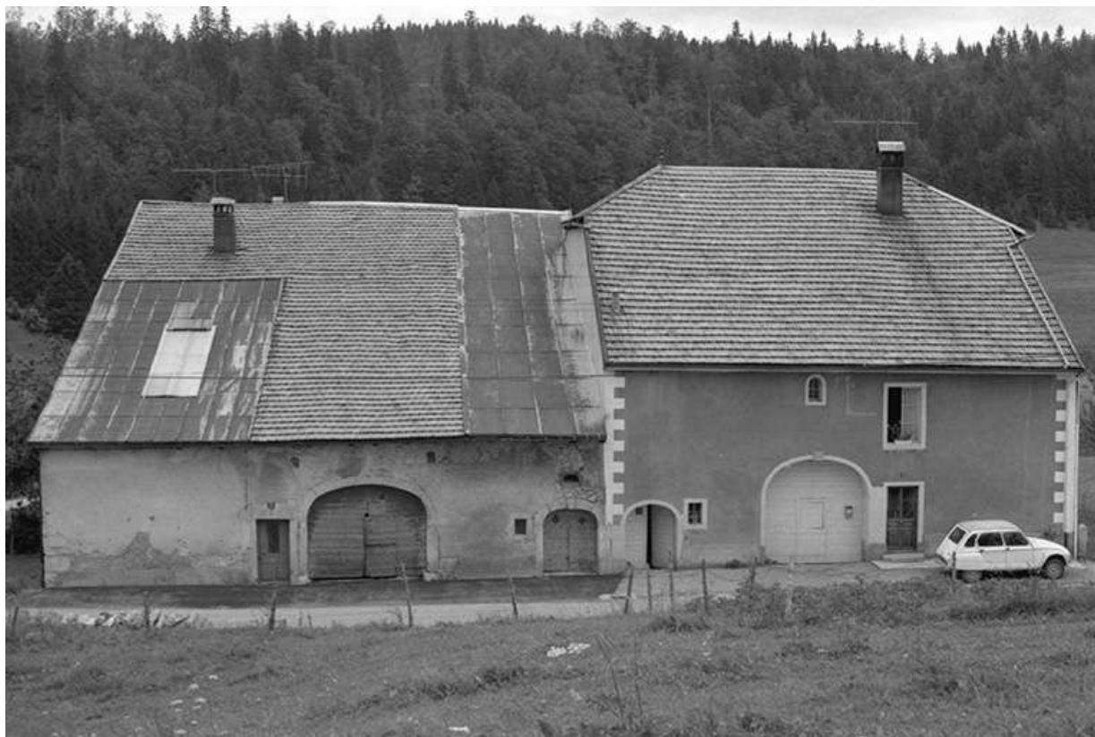
Ferme datée de 1880 et 1706, situées 15 et 15 bis avenue des Turquoises : façades antérieures. 25, Petite-Chaux
