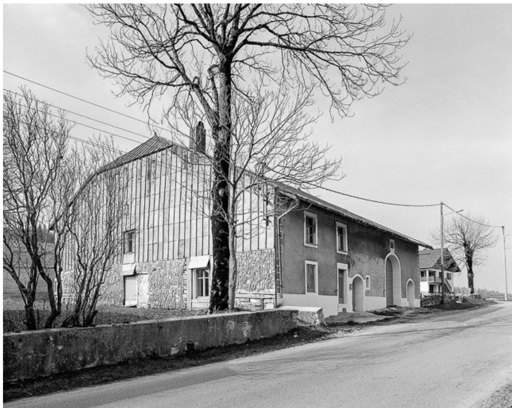
Ferme située 5 Grande Rue au lieudit Chez Vuillet : façades antérieure et latérale gauche. 25, Petite-Chaux
