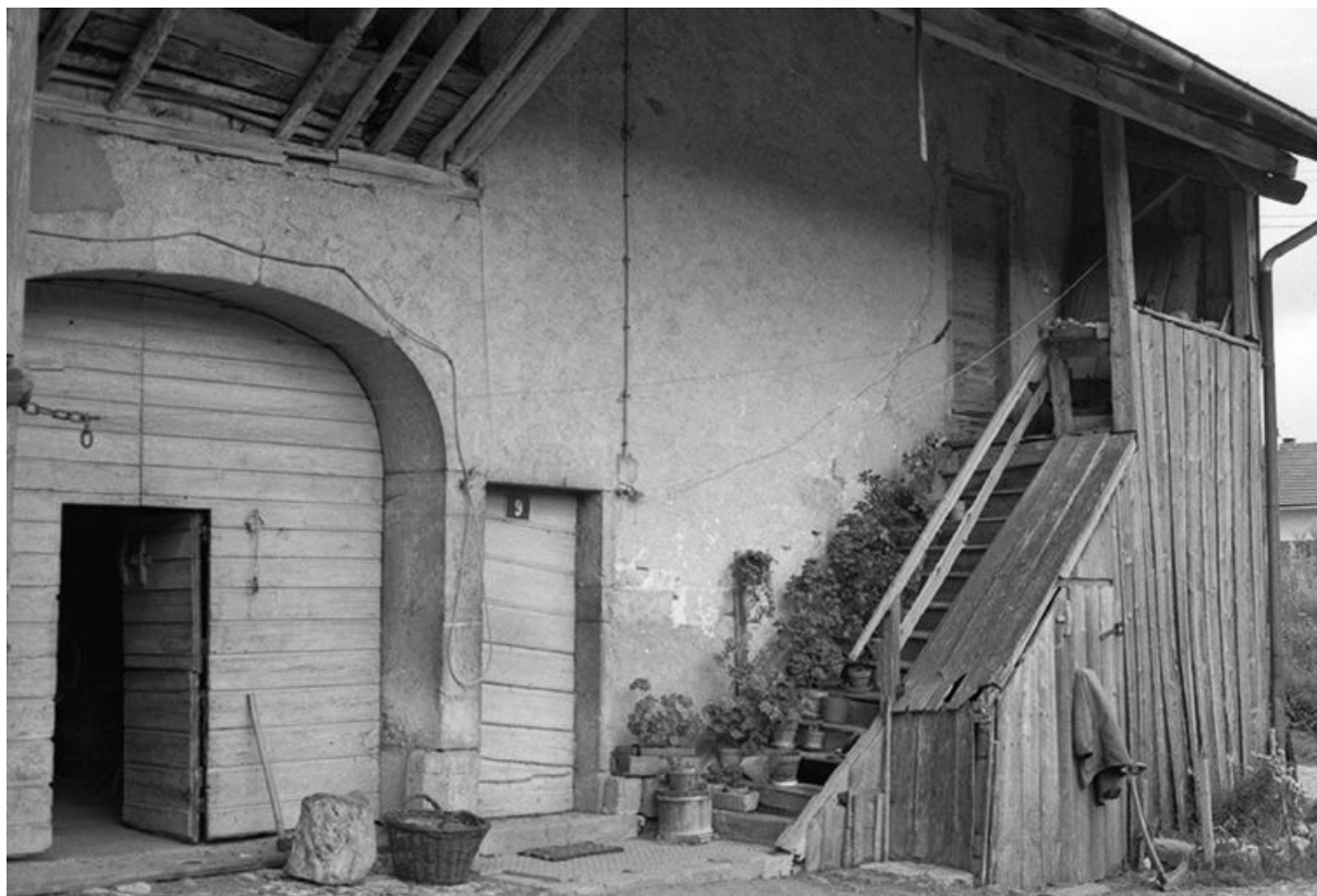
Ferme datée de 1880 et 1706, située 15 et 15 bis avenue des Turquoises : entrée et porte de grange. 25, Petite-Chaux
