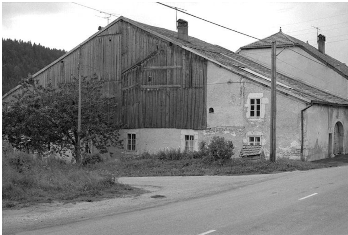
Ferme datée de 1880 et 1706, situées 15 et 15 bis avenue des Turquoises : façades antérieure et latérale gauche. 25, Petite-Chaux
