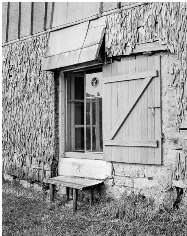
Ferme située 5 Grande Rue au lieudit Chez Vuillet : détail : fenêtre de la cuisine. 25, Petite-Chaux
