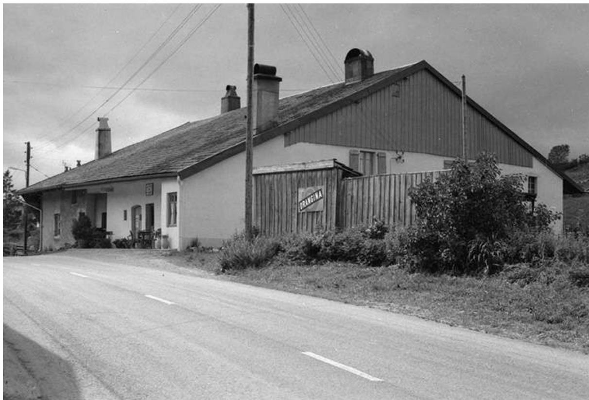
Ferme datée de 1774, située 34 avenue des Turquoises : façade antérieure et pignon droit. 25, Petite-Chaux
