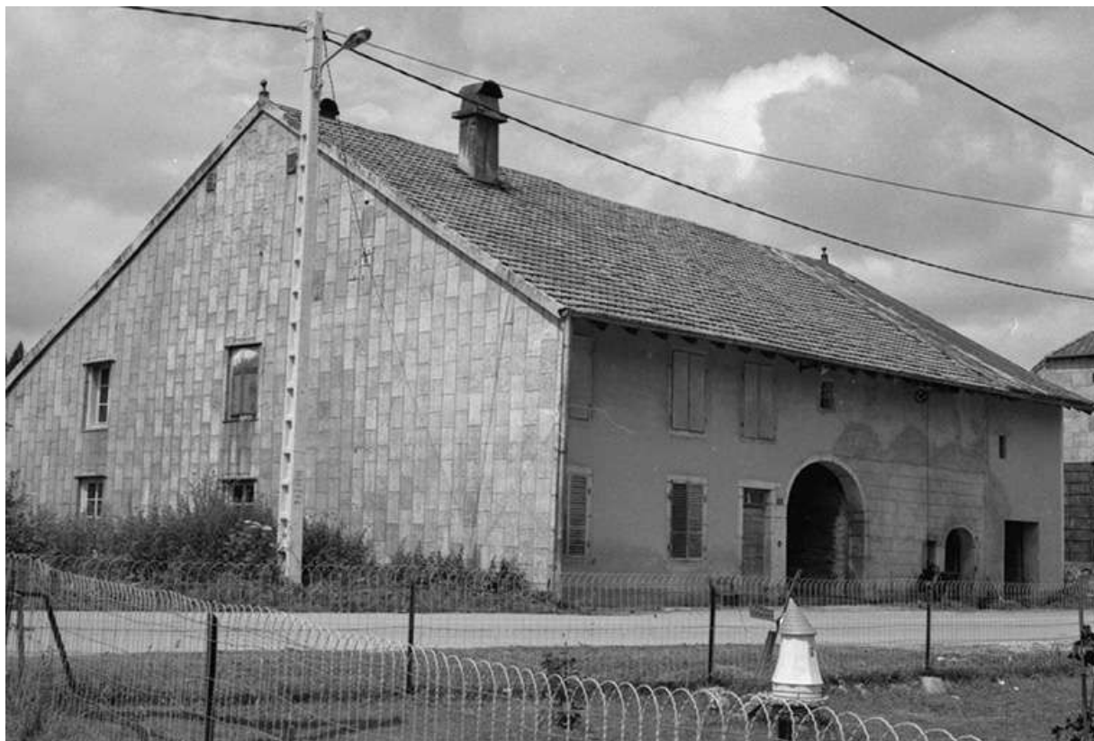
Ferme datée de 1859, située 40 avenue des Turquoises : façades antérieure et latérale gauche. 25, Petite-Chaux
