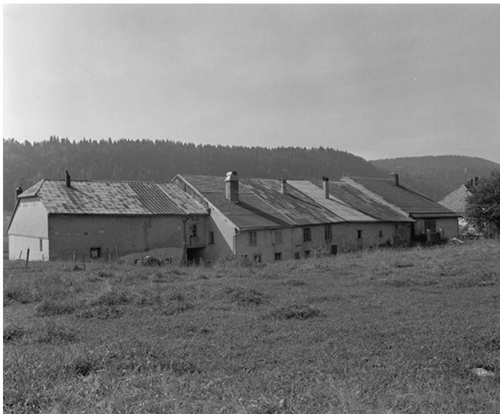
Façades postérieures des fermes situées avenue des Turquoises. 25, Petite-Chaux
