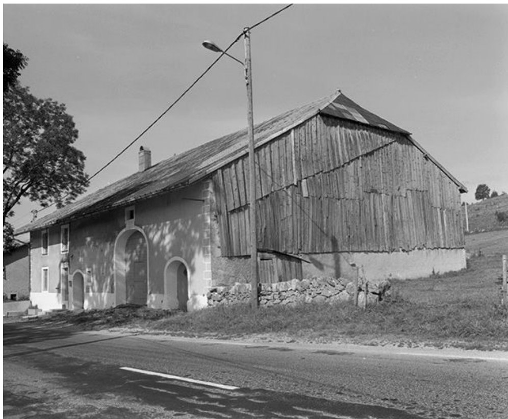
Ferme située 5 Grande Rue au lieudit Chez Vuillet : façades antérieure et latérale droite. 25, Petite-Chaux
