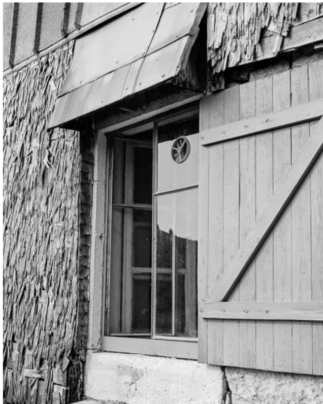
Ferme située 5 Grande Rue au lieudit Chez Vuillet : détail : fenêtre de la cuisine. 25, Petite-Chaux
