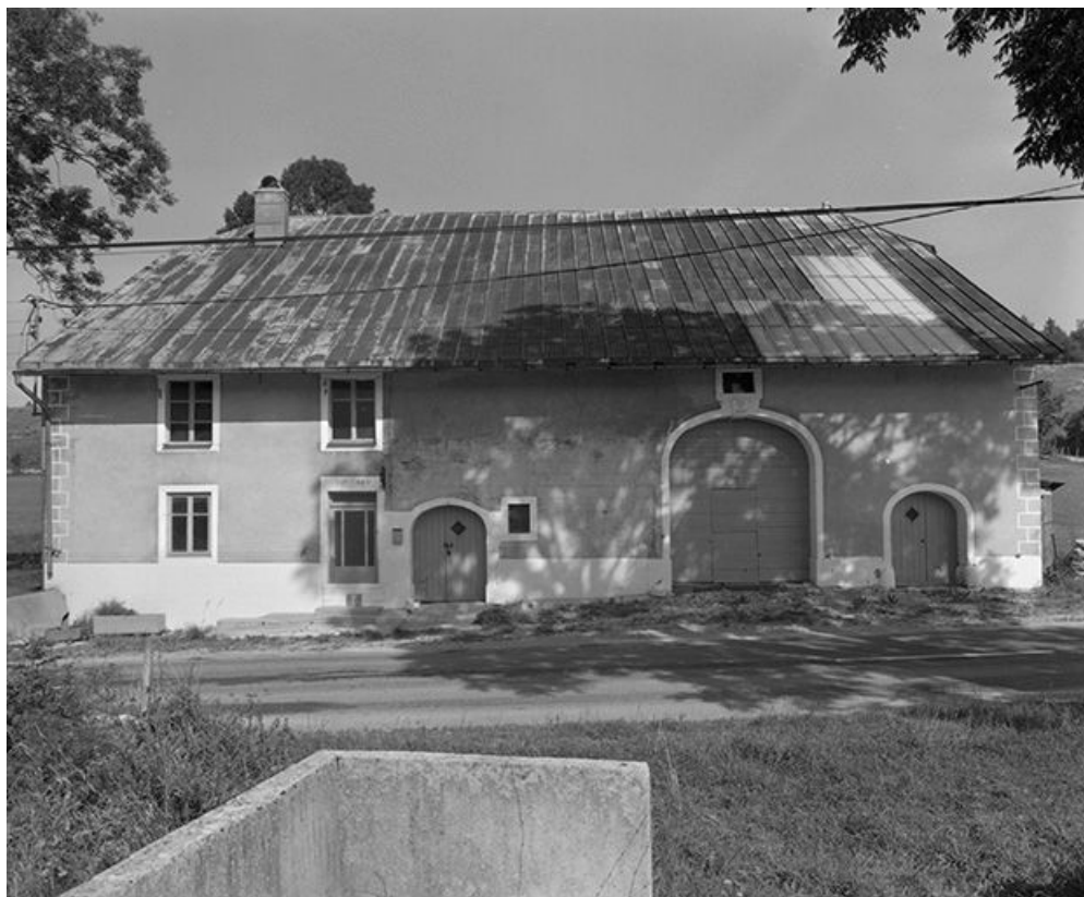
Ferme située 5 Grande Rue au lieudit Chez Vuillet : façade antérieure. 25, Petite-Chaux
