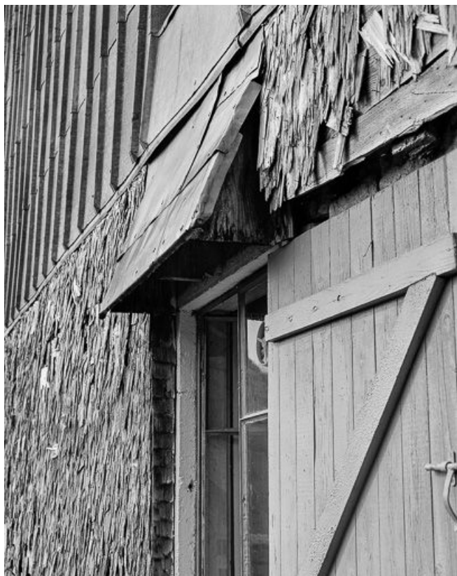
Ferme située 5 Grande Rue au lieudit Chez Vuillet : détail de la "talvanne". 25, Petite-Chaux
