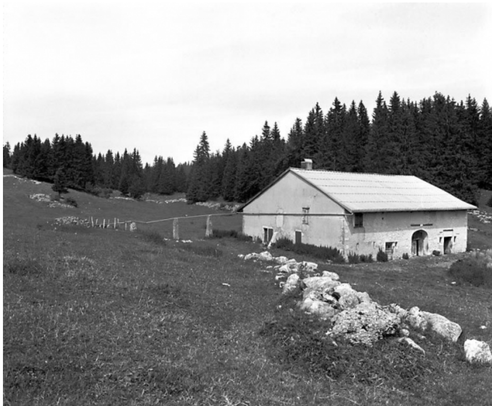
Vue d'ensemble dans le site.
