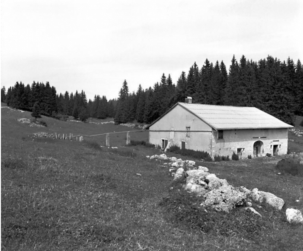
Vue d'ensemble dans le site.
