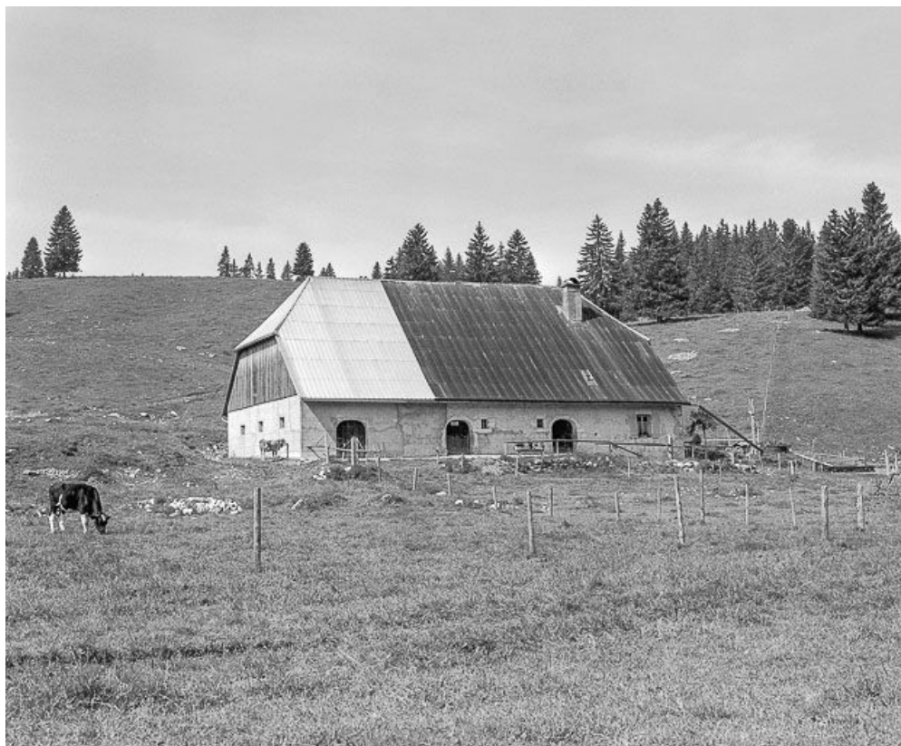
Pignon postérieur et goutterot gauche.
