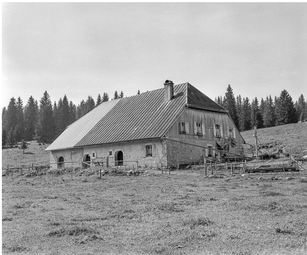
Façade antérieure et latérale gauche.
