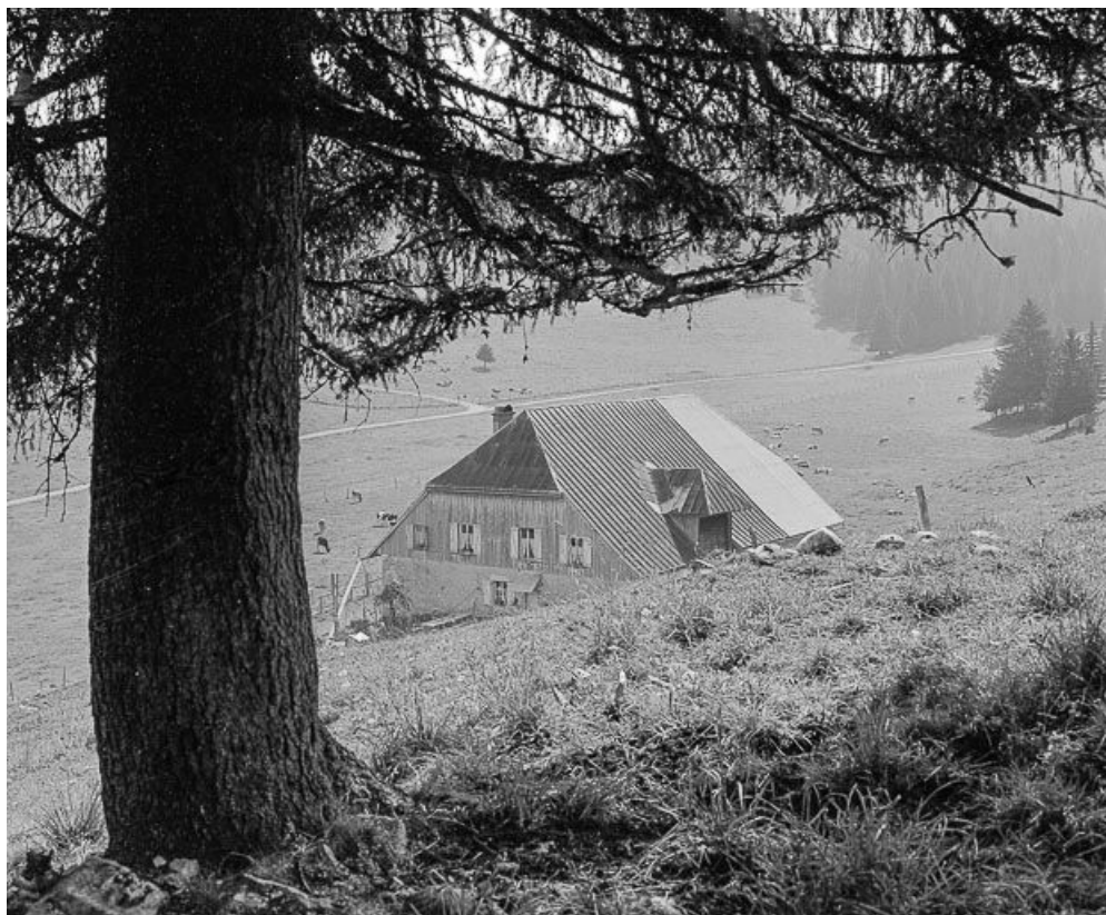
Pignon antérieur et goutterot droit.
