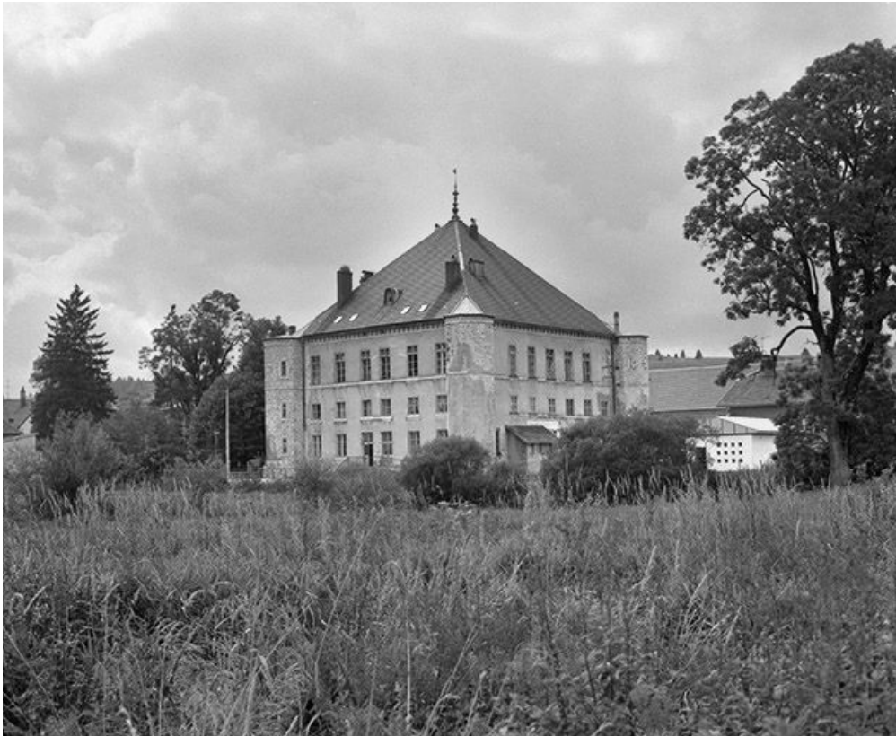
Façade postérieure et latérale gauche. 25, Mouthe Grande Rue
