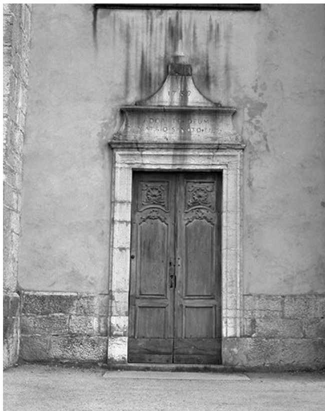
Porte d'entrée latérale. 25, Mouthe
