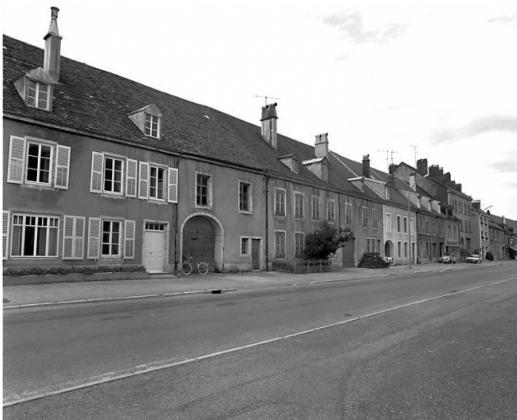
La Grande Rue du n° 12 à 30. 25, Mouthe Grande Rue
