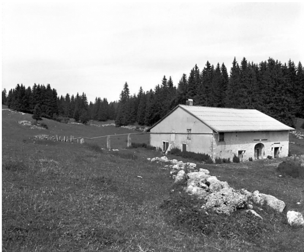
Vue d'ensemble dans le site.
