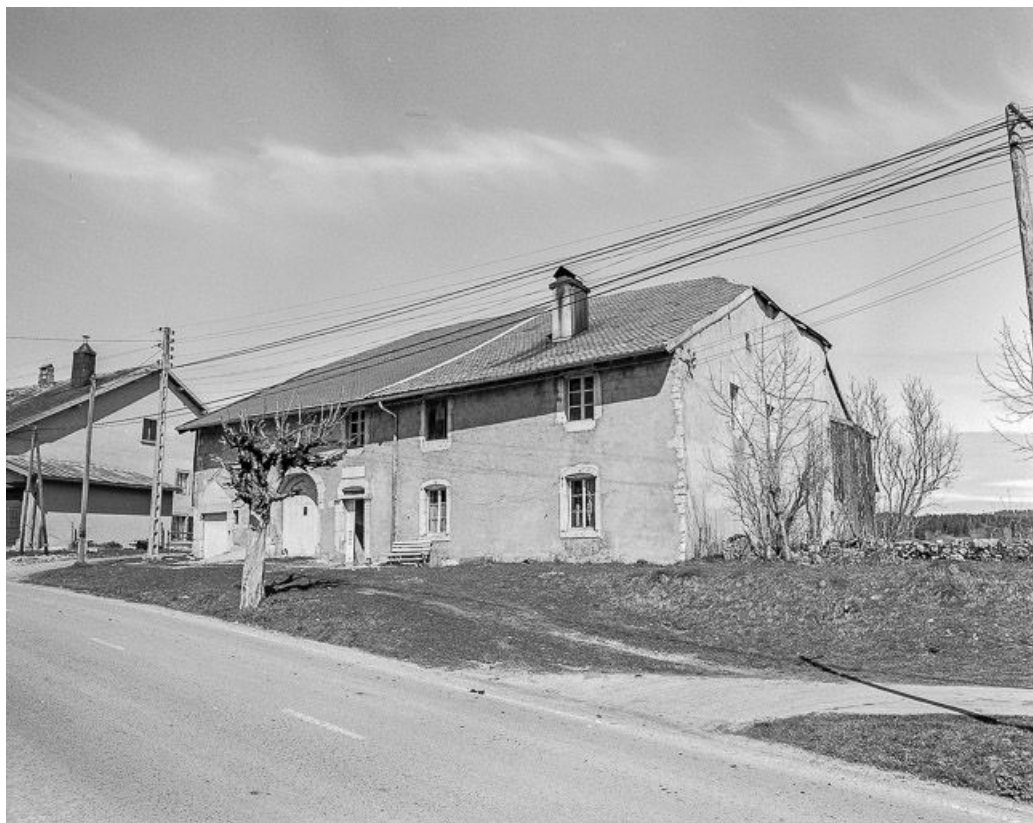
Façades antérieure et latérale droite.
