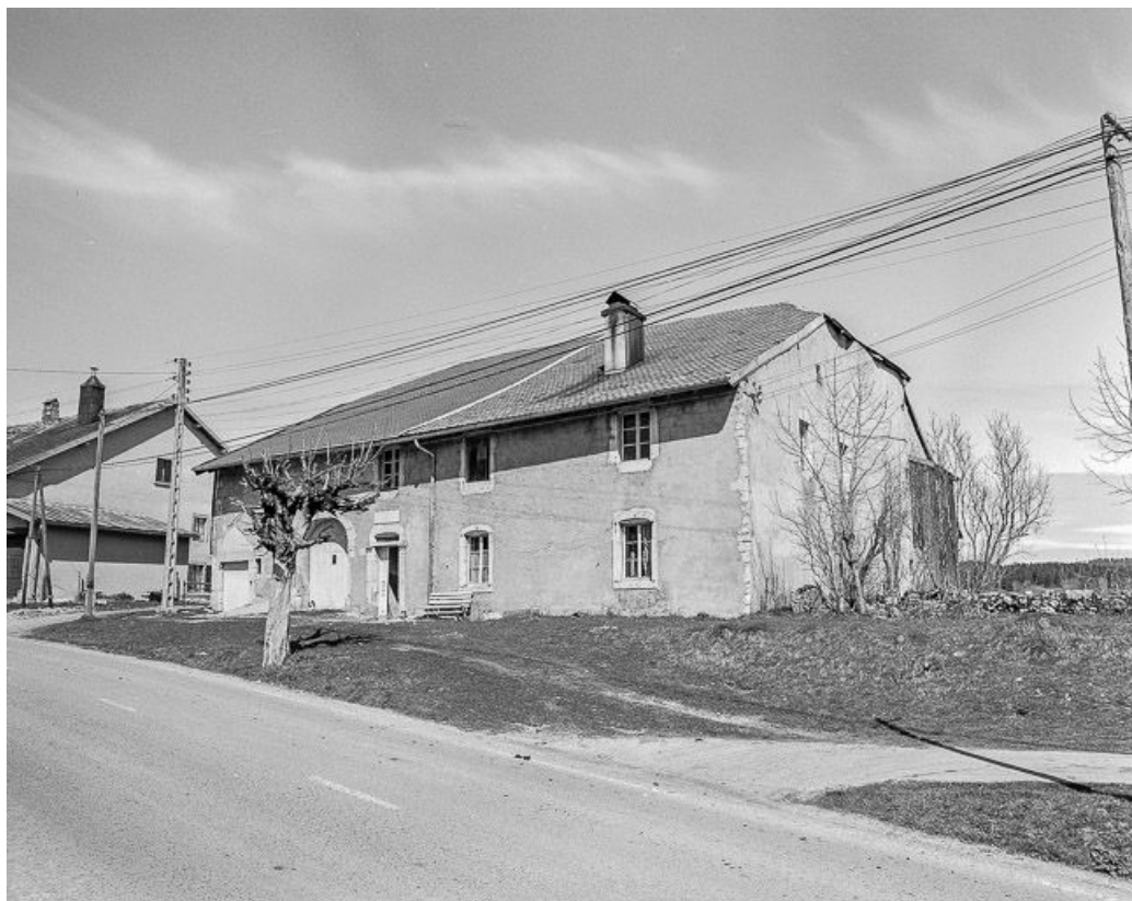
Façades antérieure et latérale droite.
