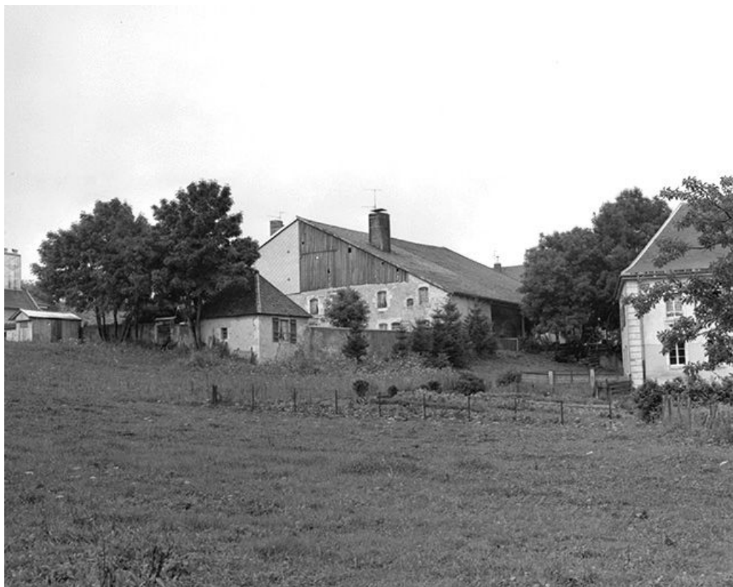
Pignon habitation et mur d'enclos du jardin potager.
