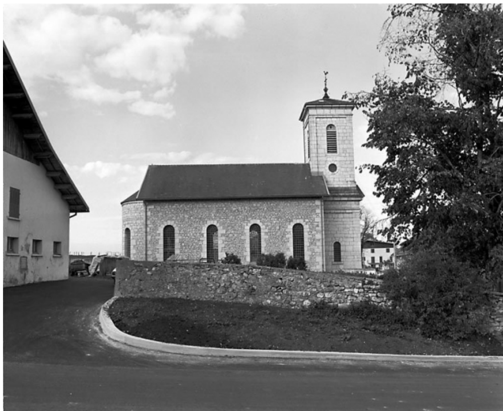
Façade latérale droite.
