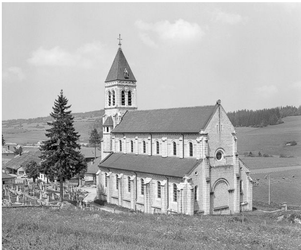
Façades postérieure et latérale droite.
