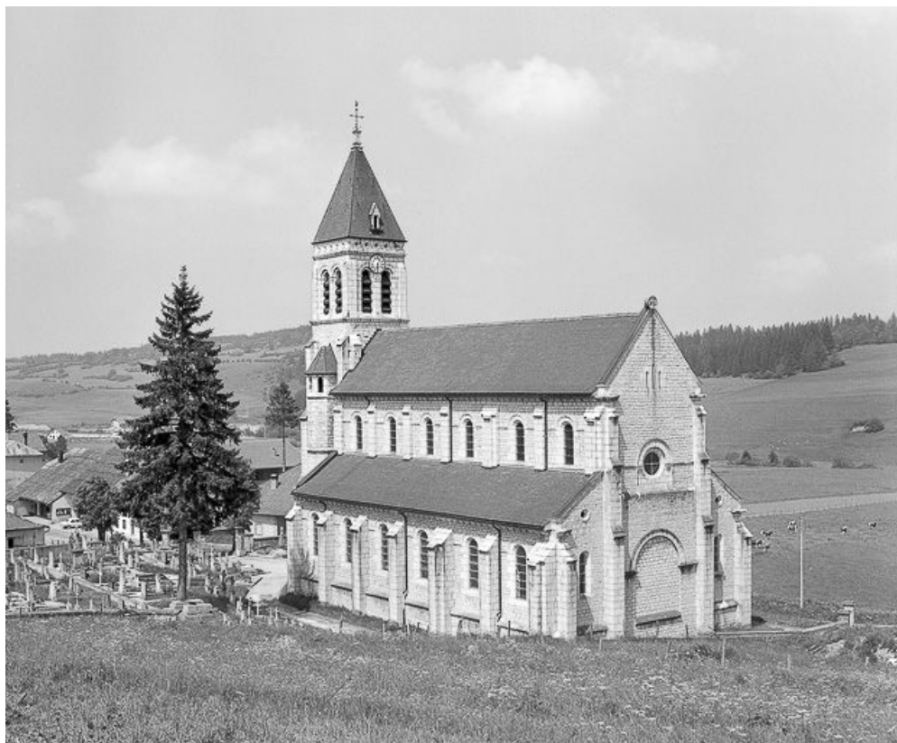
Façades postérieure et latérale droite.
