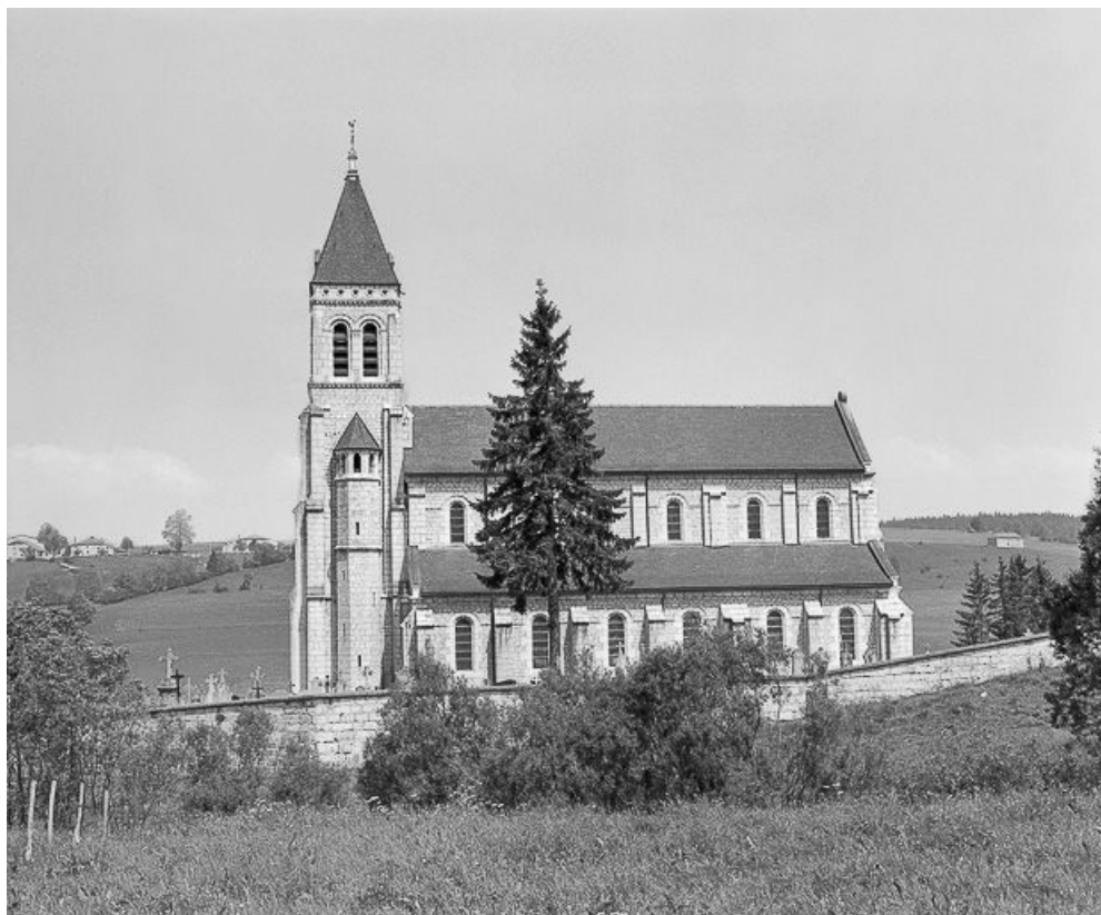
Façade latérale droite.
