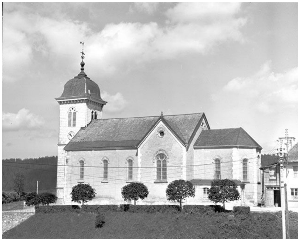
Extérieur : façade droite.
