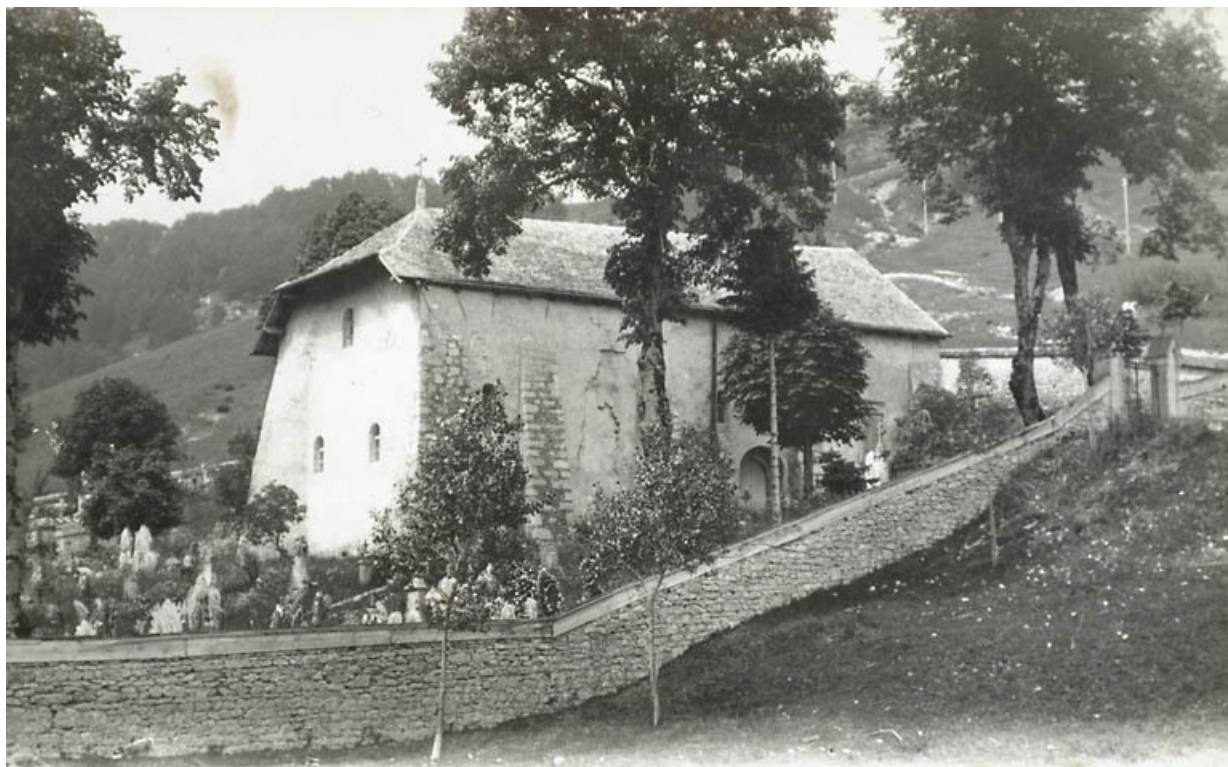
Façades latérale gauche et postérieure.
