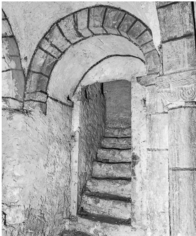
Crypte : escalier menant à la nef.
