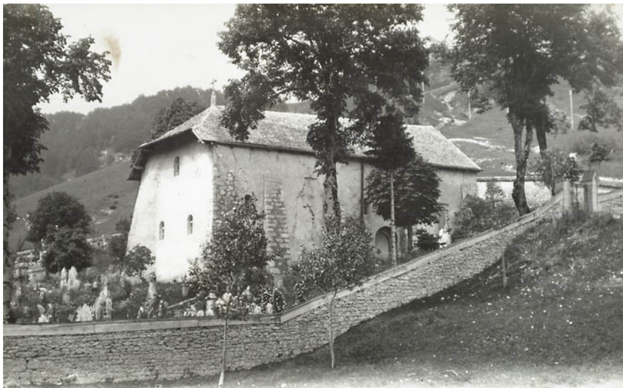
Façades latérale gauche et postérieure.
