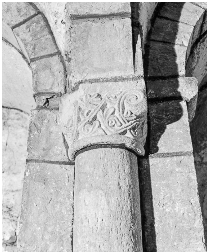
Crypte : chapiteau du mur ouest, côté nord.
