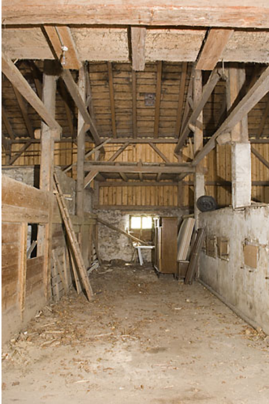
Grange : travée centrale.
