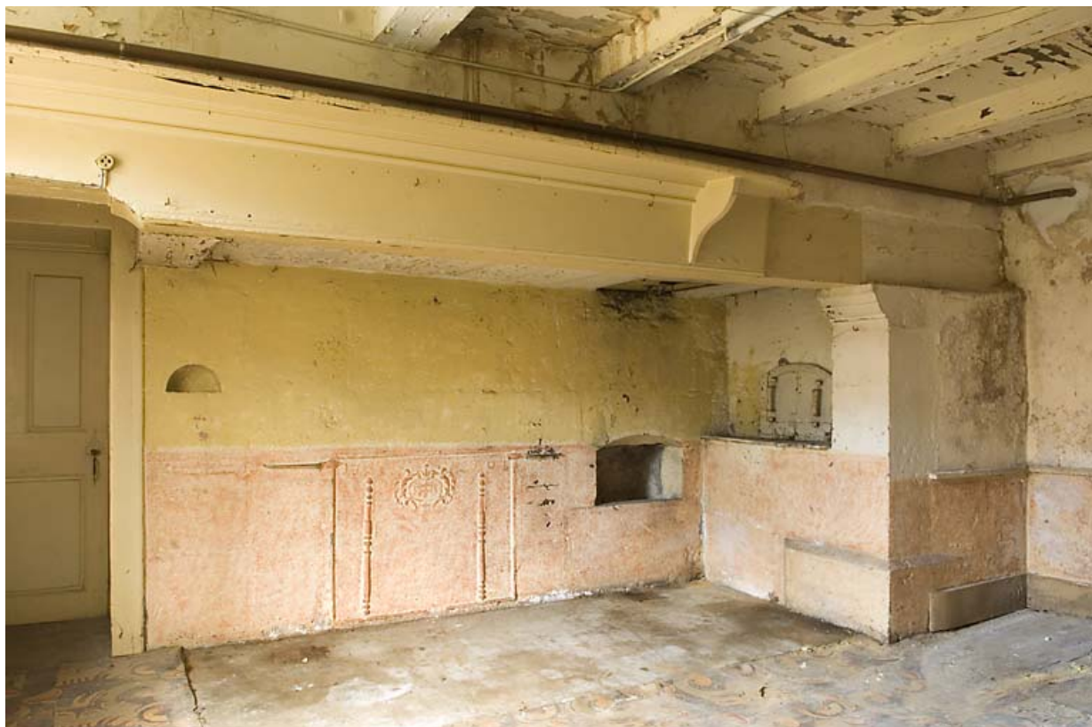
Ferme au 17 rue du Faubourg : cuisine avec cheminée et four à pain. 25, Jougne
