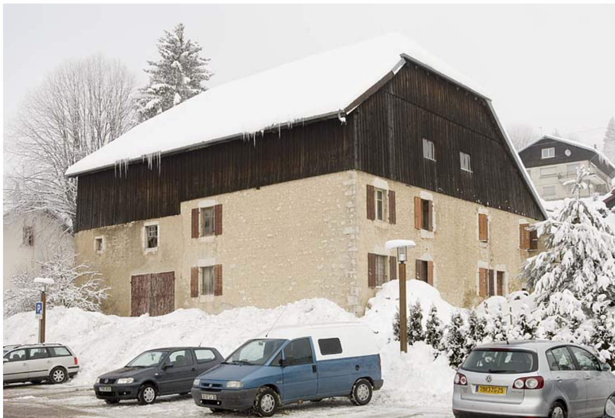
Façades postérieure et latérale gauche, en hiver. 25, Jougne, 17 rue du Faubourg
