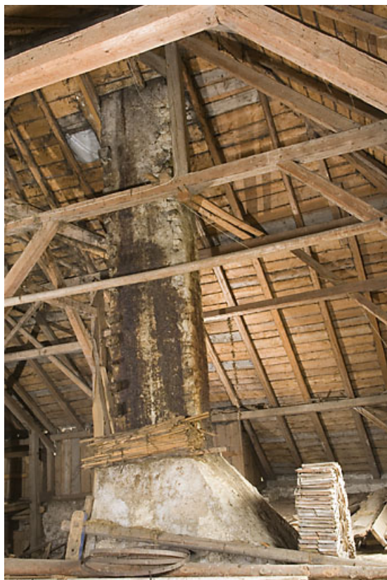
Grange : conduit de cheminée.
