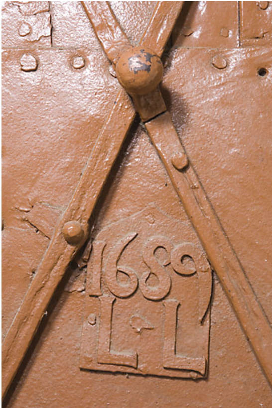
Ferme au 17 rue du Faubourg : date et initiales sur la porte coupe-feu. 25, Jougue
