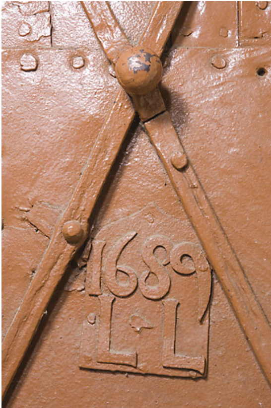
Ferme au 17 rue du Faubourg : date et initiales sur la porte coupe-feu. 25, Jougne
