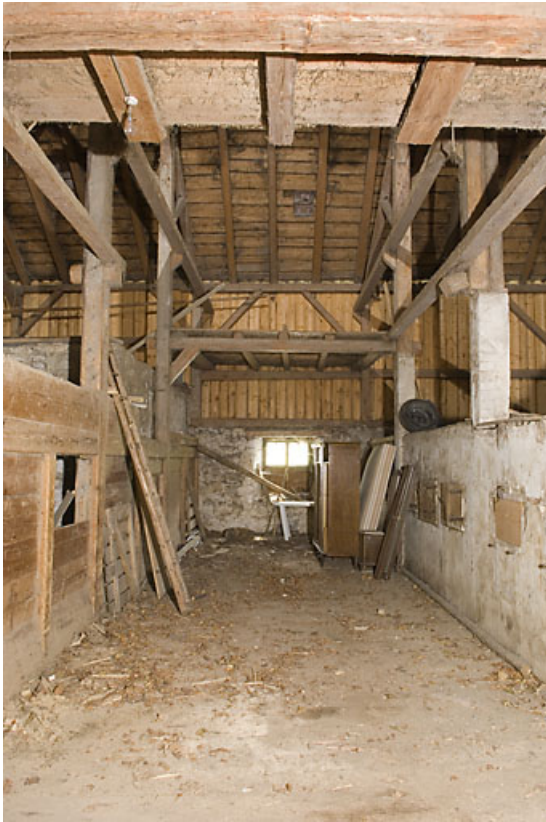
Grange : travée centrale.
