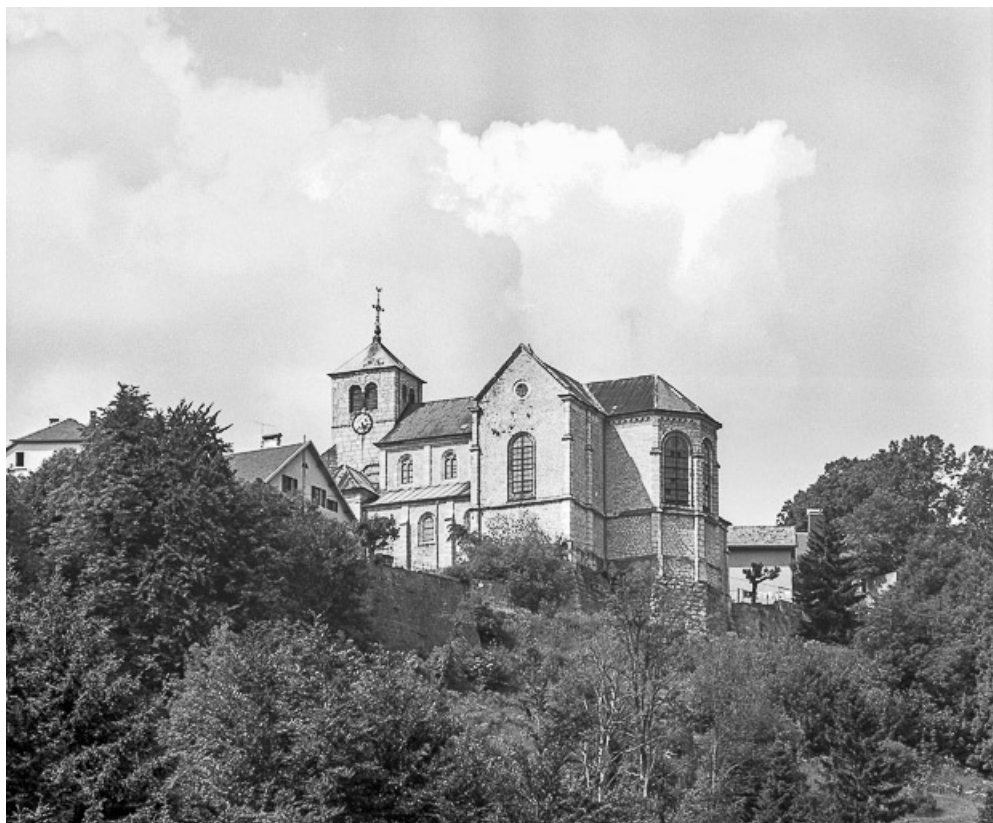
Façade latérale droite.
