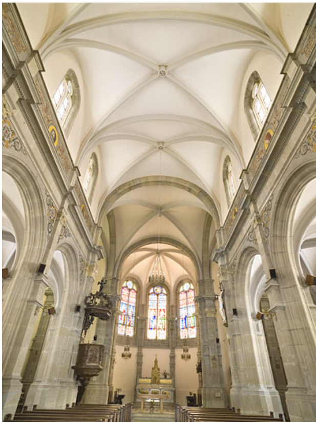
Voûtes de la nef, vues de l'entrée.
