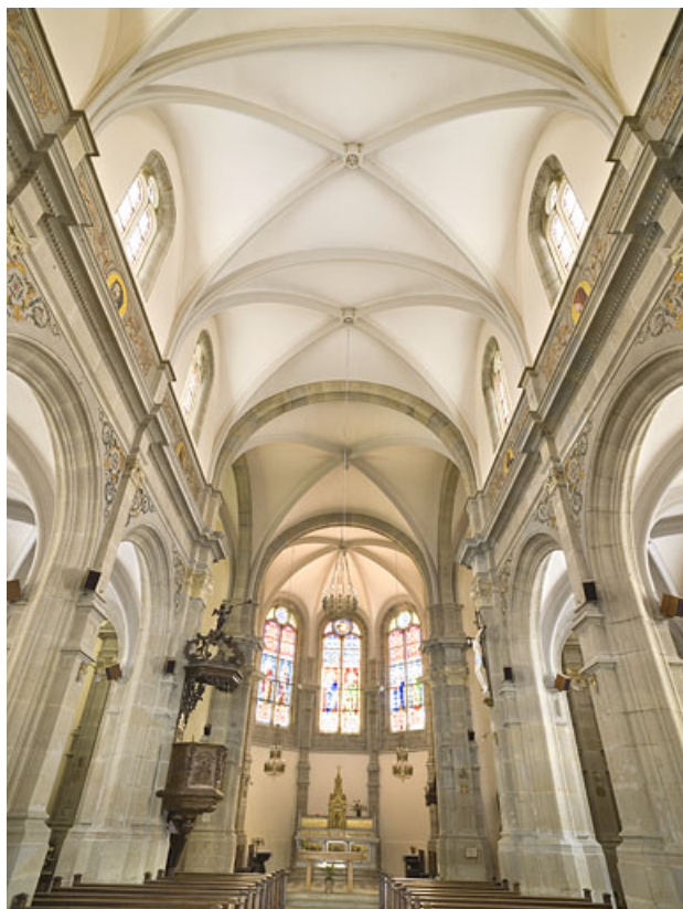
Voûtes de la nef, vues de l'entrée.
