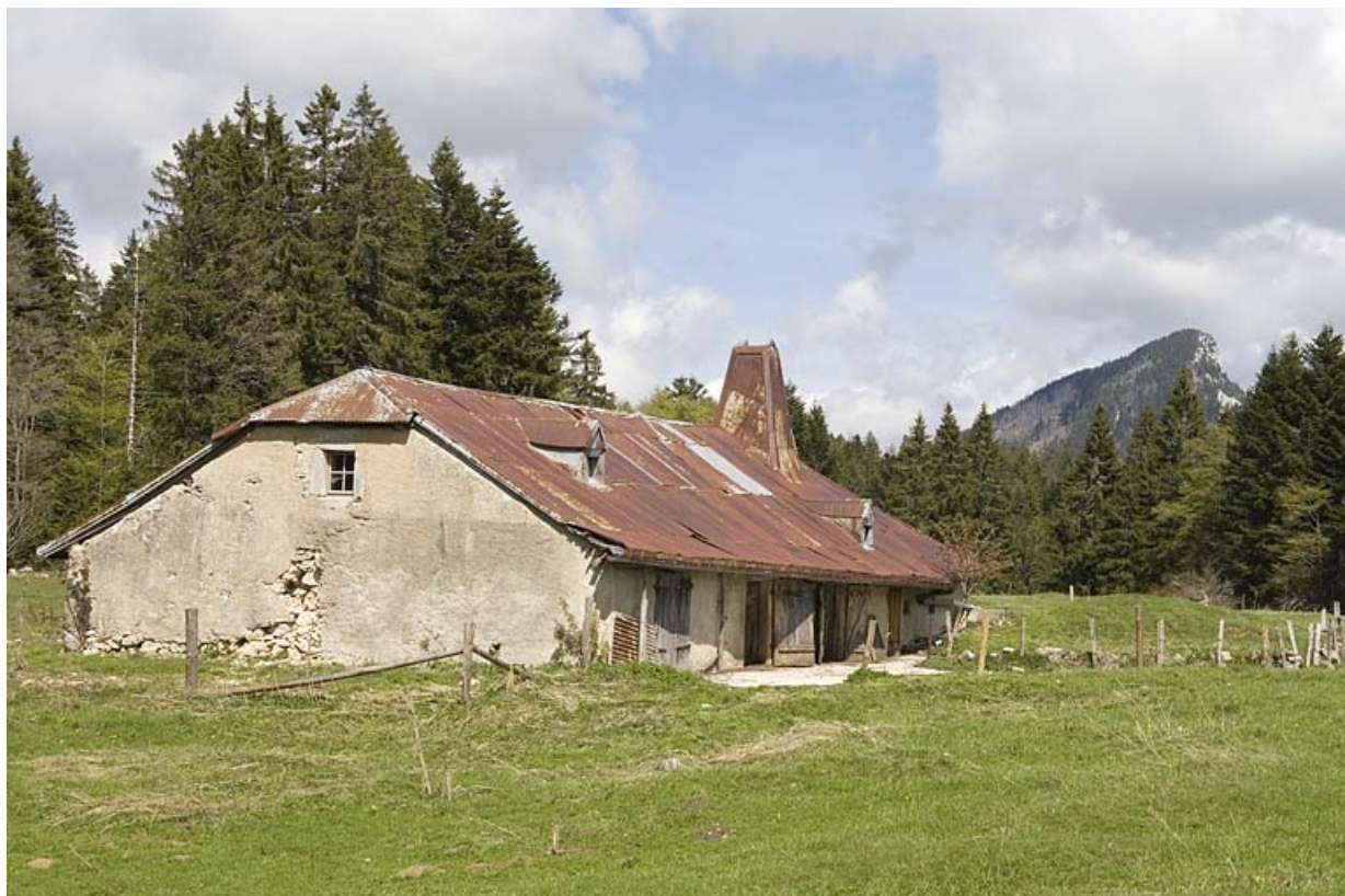
Vue générale de la Bécasse et de l'Aiguillon de Baulmes. 25, Jougne
